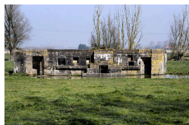
Vue générale, vers le nord. On retrouve les entrées latérales et, au centre, la resserre à mitrailleuse Phot. Jean-Marc Ramette IVR32_20165901017NUCA
