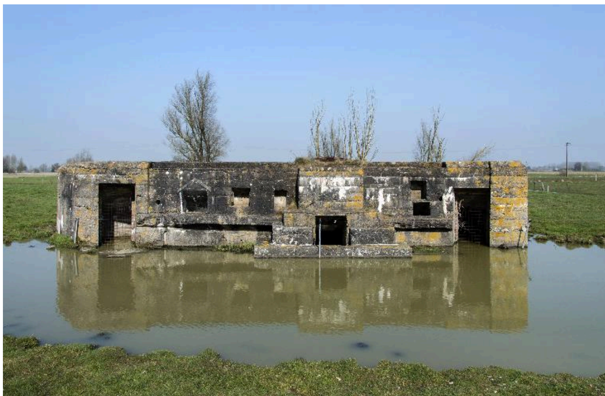
Vue générale, vers le nord. On retrouve les entrées latérales et, au centre, la resserre à mitrailleuse
