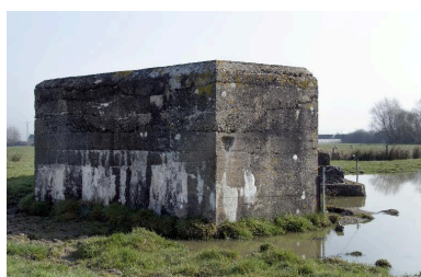
Vue latérale, vers l'est Phot. Jean-Marc Ramette IVR32_20165901011NUCA
