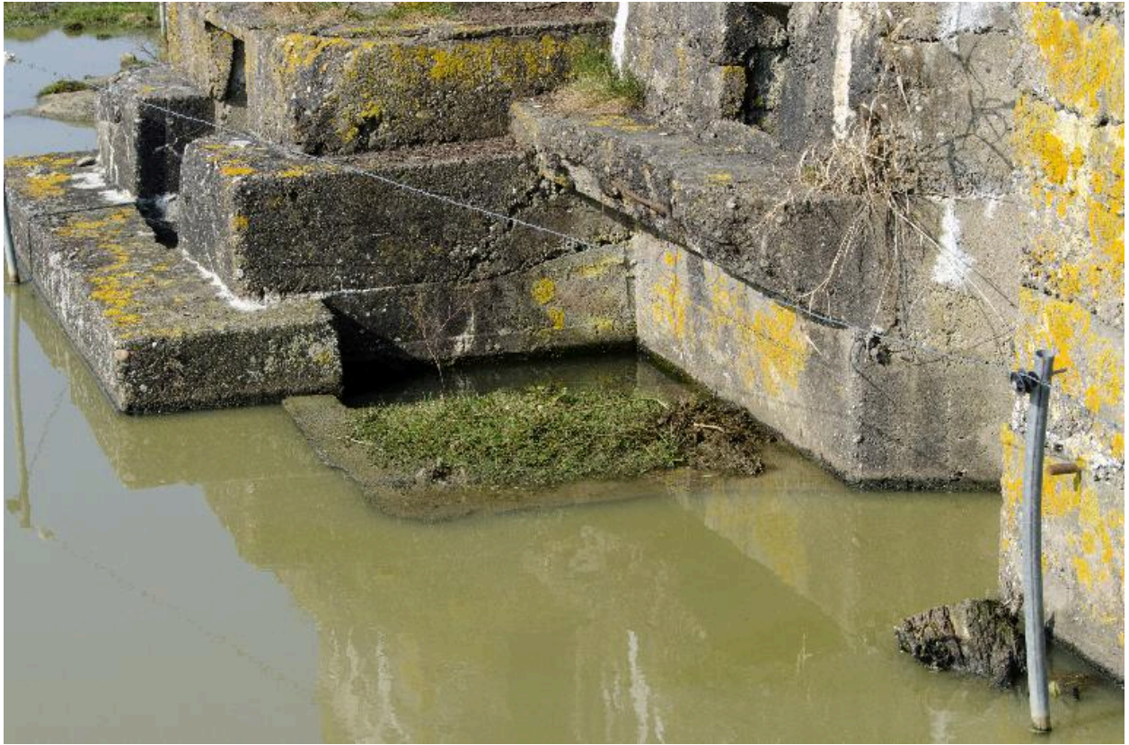
Elévation sud. Détail d'un puisard
