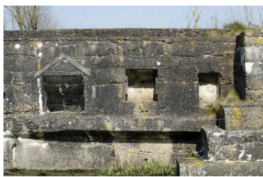
Elévation sud, banquette de tir et niches à munitions Phot. Jean-Marc Ramette IVR32_20165901005NUCA
