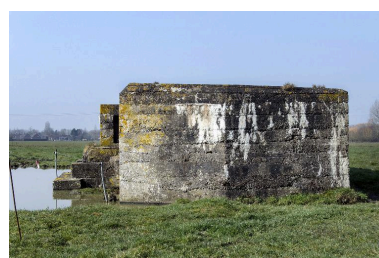
Vue latérale vers l'ouest Phot. Jean-Marc Ramette IVR32_20165901012NUCA
