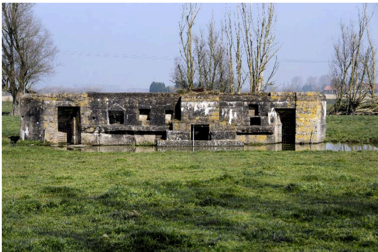
Vue générale, vers le nord. On retrouve les entrées latérales et, au centre, la resserre à mitrailleuse
