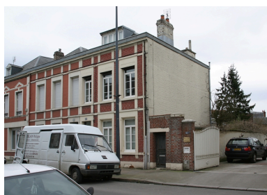
Deux bâtiments d'habitation jumelés. Phot. Frédéric Pillet IVR22_20070205196NUCA
