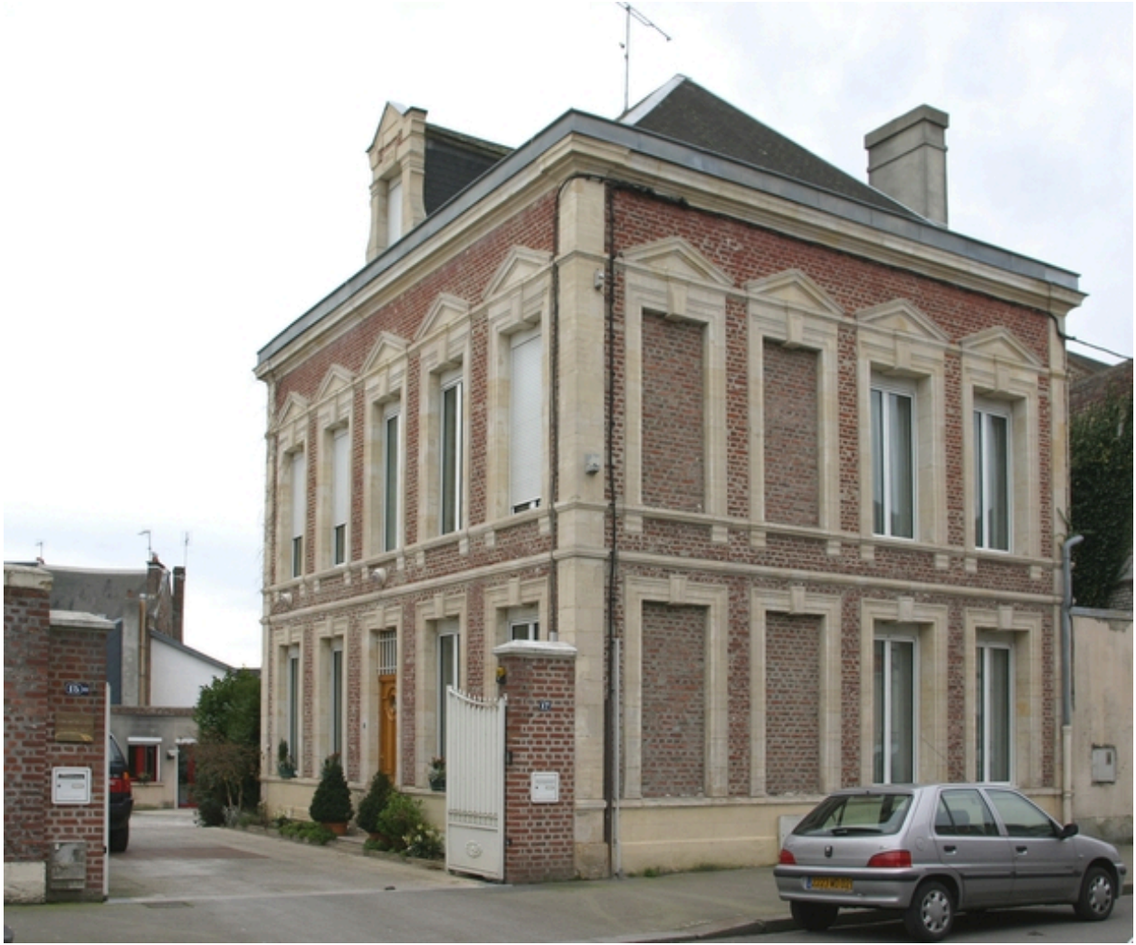
Le logement patronal.
