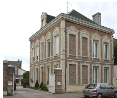
Le logement patronal. Phot. Frédéric Pillet IVR22_20070205195NUCA
