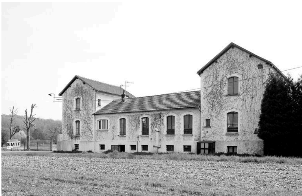
Le bureau et la conciergerie : façade ouest.
