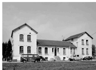
Le bureau et la conciergerie : façade est. Phot. Patrick Glotain IVR22_19936000402X
