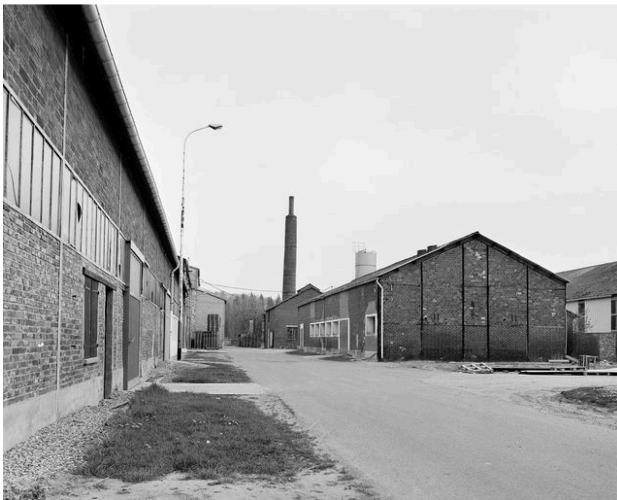
Atelier de fabrication avec la cheminée d'usine en arrière plan.
