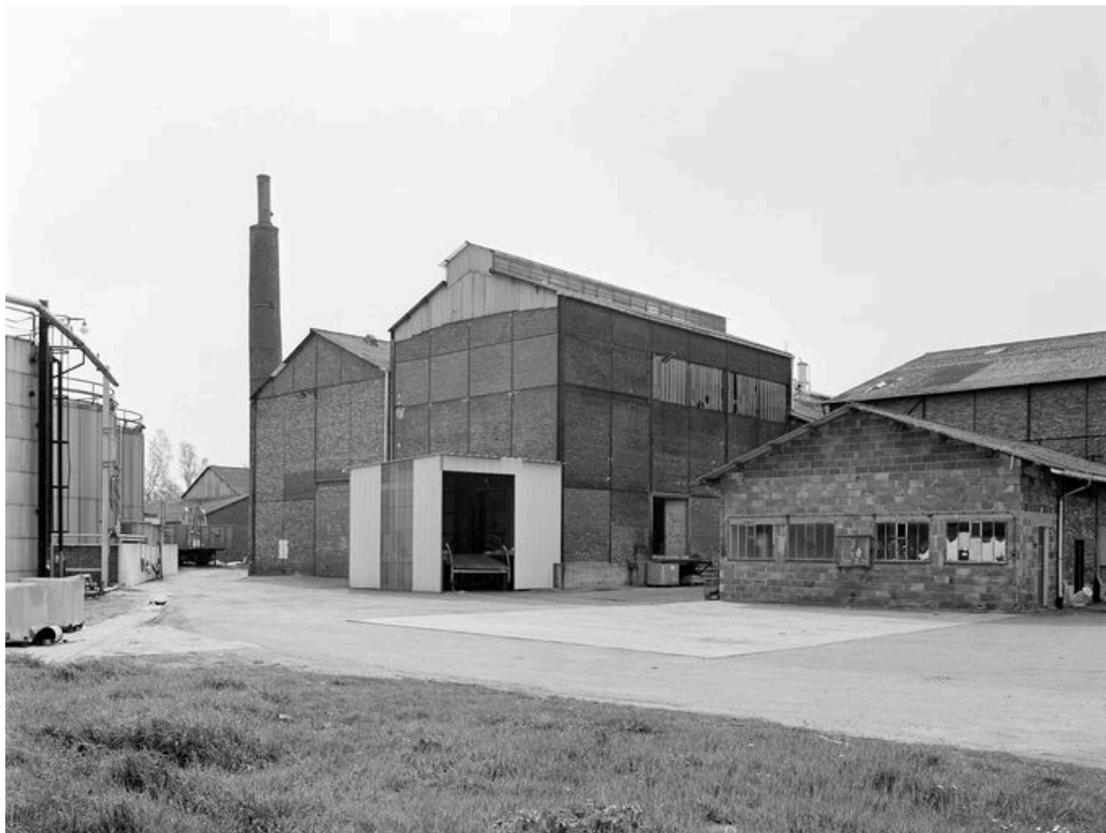
La chaufferie, pignon sud.
