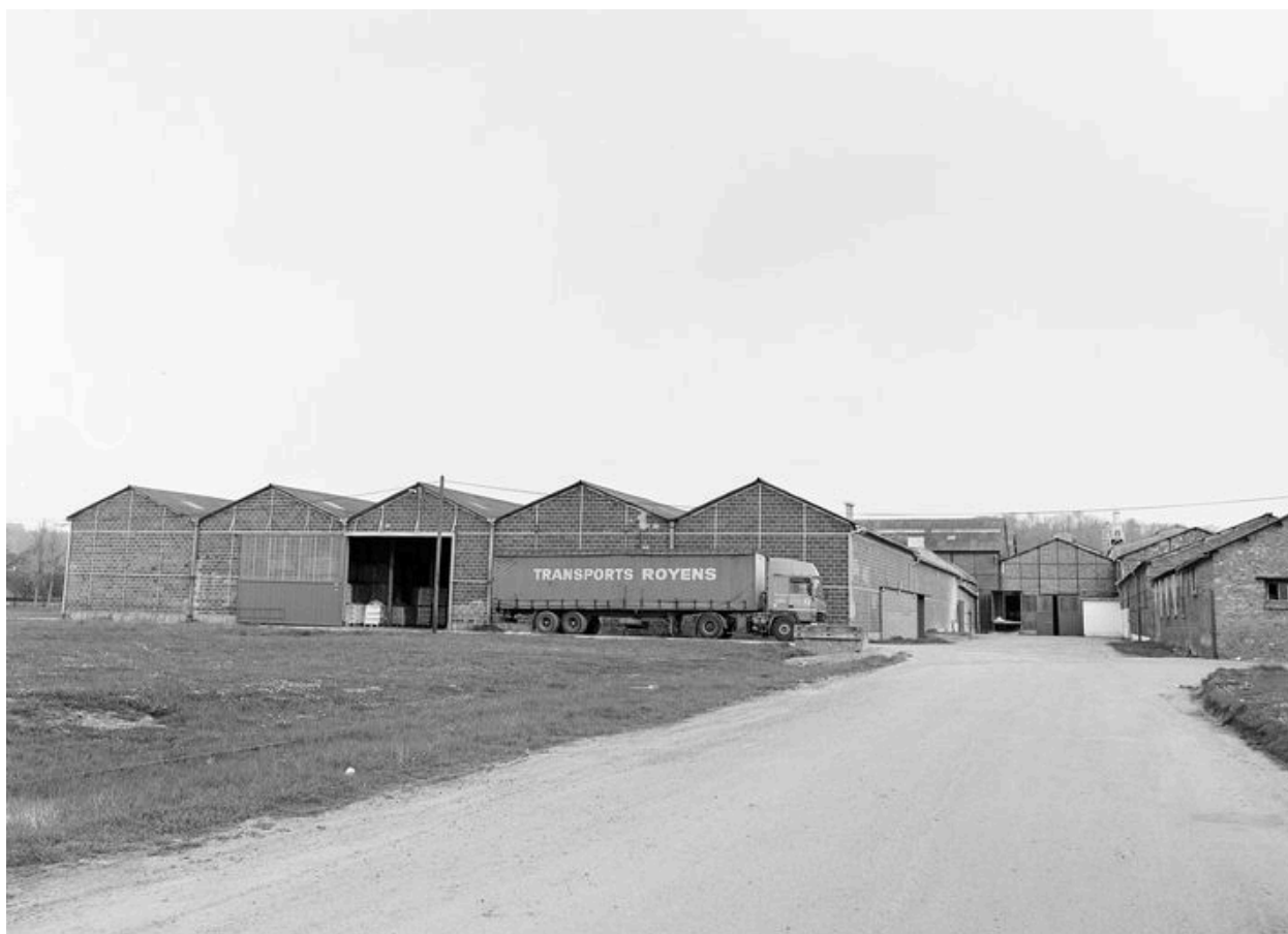
Ateliers de fabrication, pignons sud.
