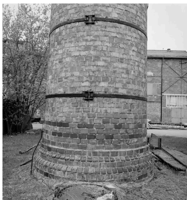
Socle de la cheminée d'usine. Phot. Patrick Glotain IVR22_19936000456X
