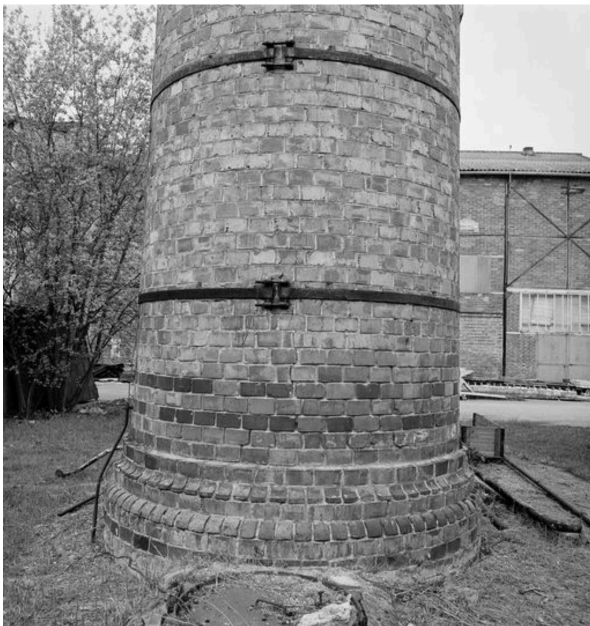
Socle de la cheminée d'usine.
