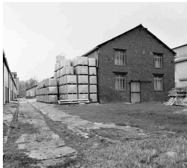
Embranchement ferroviaire avec bâtiment non identifié. Phot. Patrick Glotain IVR22_19936000454X
