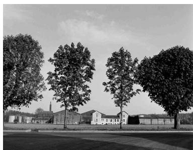
Vue générale de l'usine, côté ouest. Phot. Patrick Glotain IVR22_19936000400X
