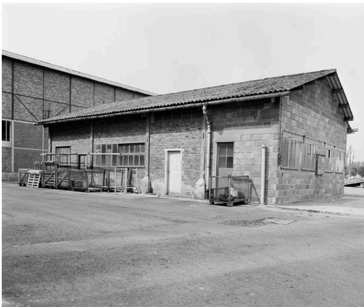
Atelier de réparation, angle nord est.
