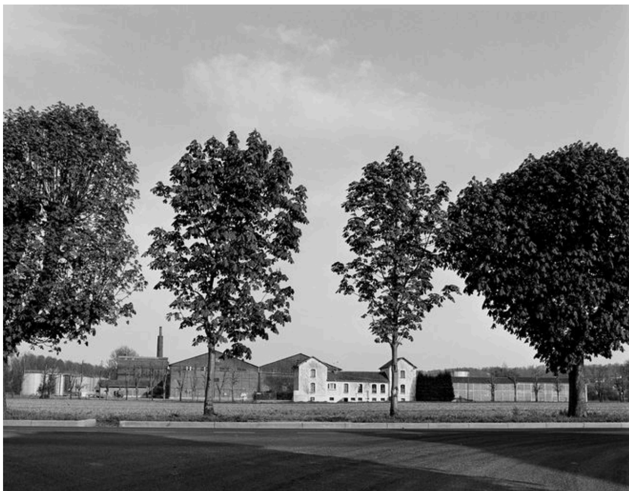
Vue générale de l'usine, côté ouest.
