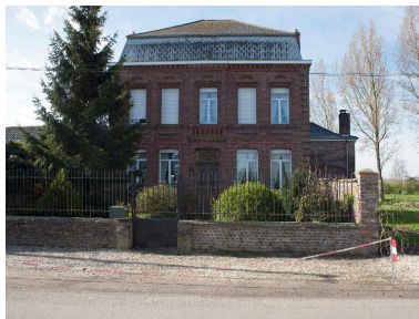
Vue générale du logis de la ferme à cour fermée du 1522 rue du Bois. Phot. Pierre Thibaut IVR31_20125901653NUCA
