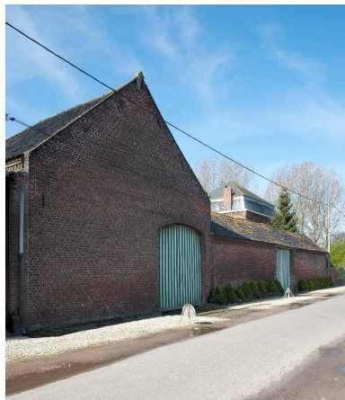
Vue générale d'une ferme à cour fermée 1522 rue du Bois. Phot. Pierre Thibaut IVR31_20125901654NUCA
