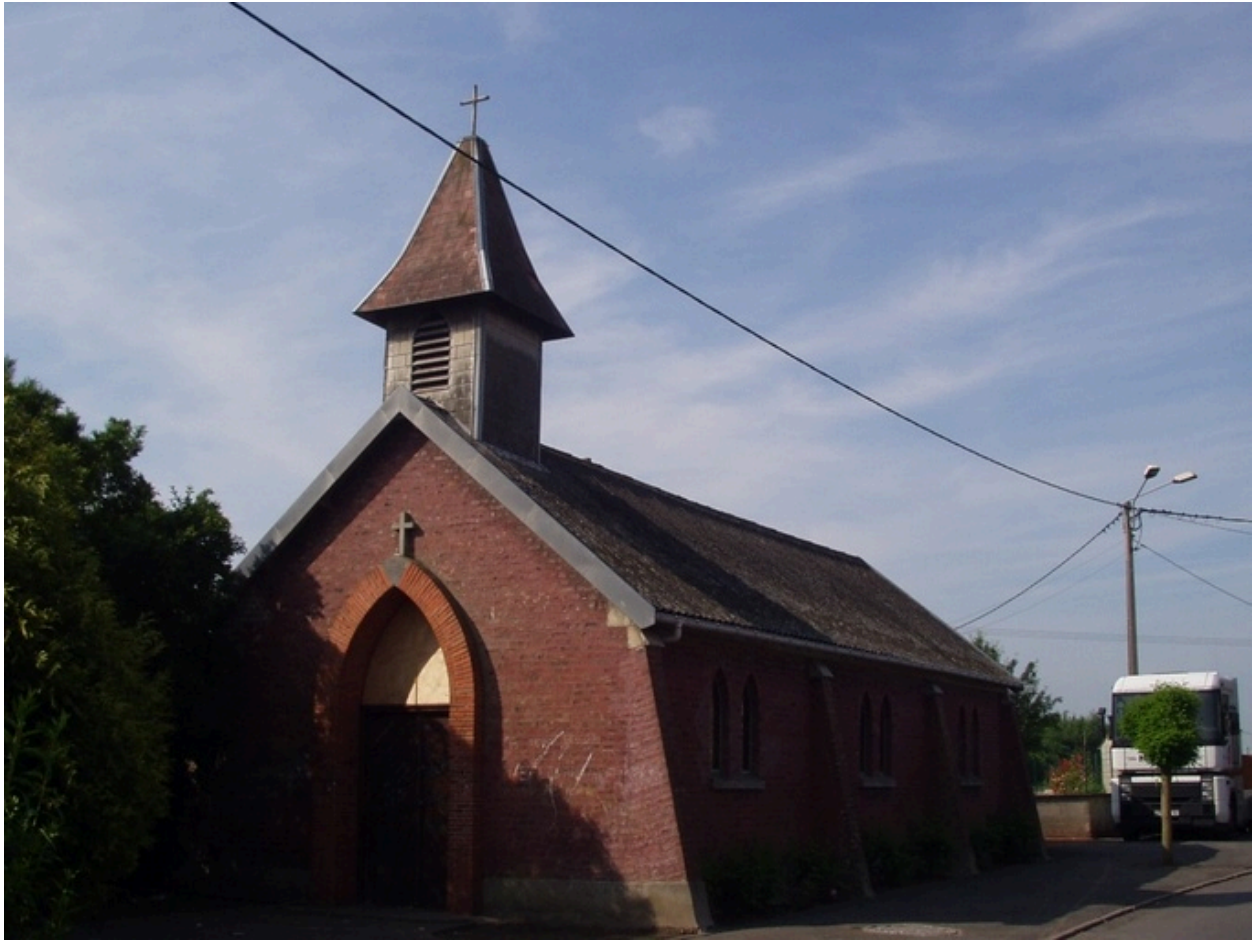
Vue de trois-quarts, vers le sud.
