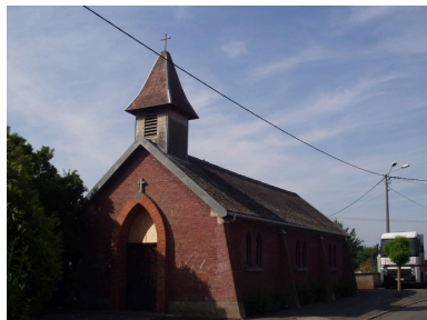
Vue de trois-quarts, vers le sud. Phot. Céline Frémaux IVR31_20055907308NUCA
