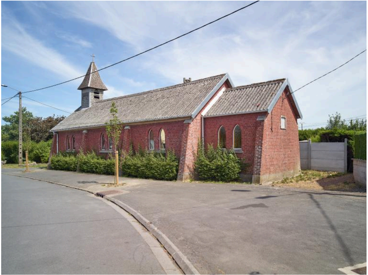
Vue de trois-quarts arrières vers le nord-est.
