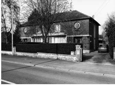
Vue générale du module (35-33 rue Anatole-France). Phot. Thierry Petitberghien IVR31_20025901223X
