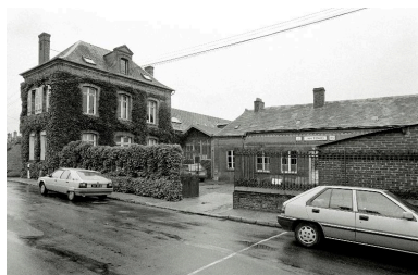
L'ancien logement patronal (vers 1894) et la cour, en 1990, vus depuis le sud-est. Phot. Francis Dubuc IVR22_19908001877Z
