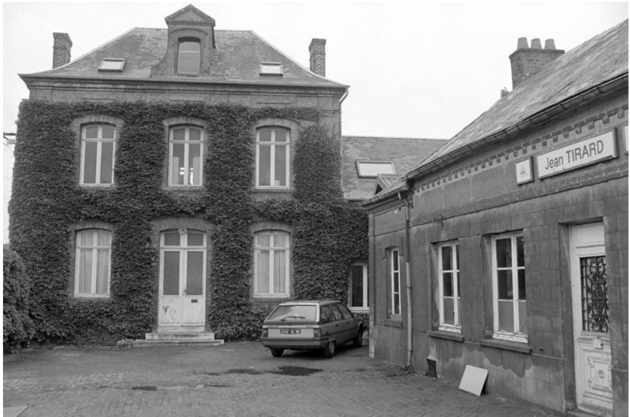
L'ancien logement patronal (vers 1894) et une partie de l'ancien logis transformé en atelier (détruit), vus depuis le sud en 1990
