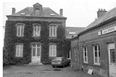
L'ancien logement patronal (vers 1894) et une partie de l'ancien logis transformé en atelier (détruit), vus depuis le sud en 1990 Phot. Francis Dubuc IVR22_19908000044Z
