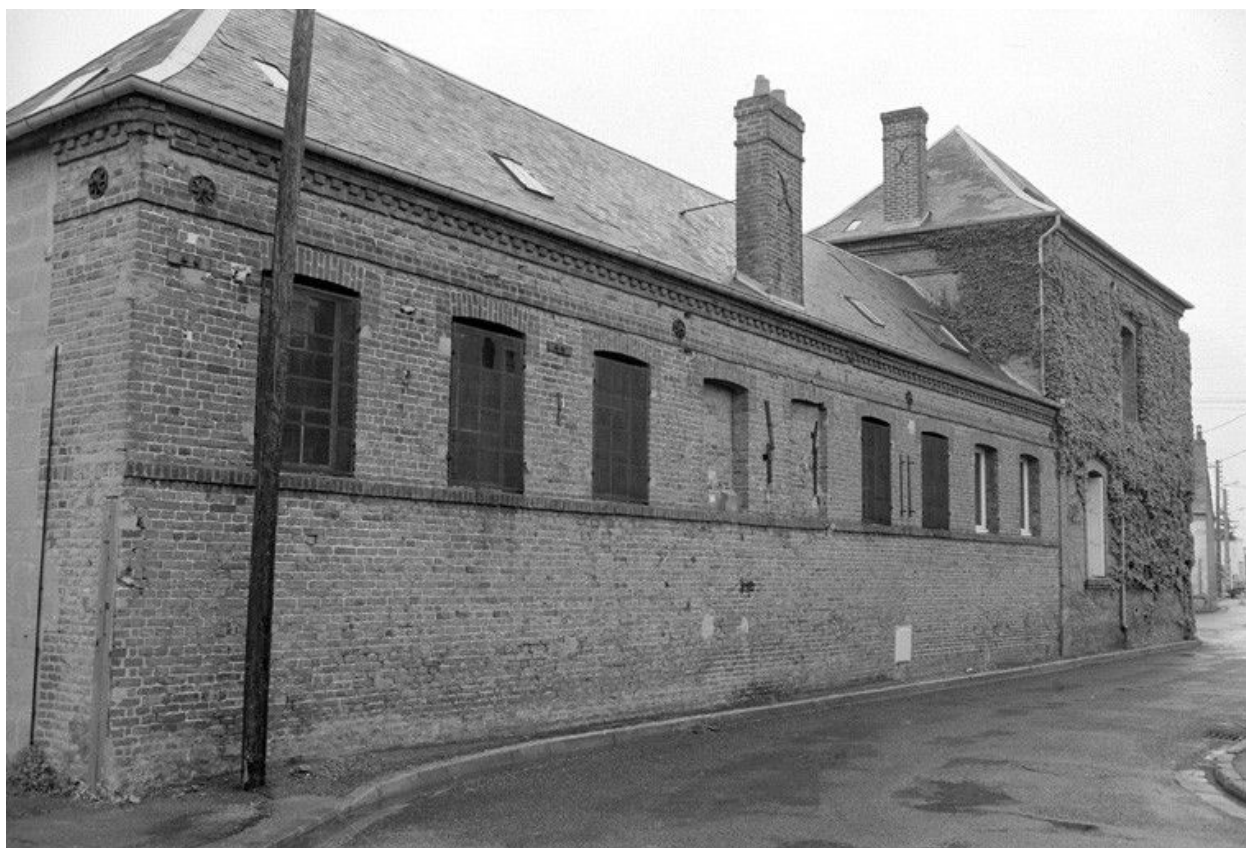
L'atelier de fabrication (vers 1891), en 1990, avant sa démolition partielle.
