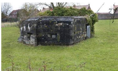
Vue générale, vers l'est Phot. Jean-Marc Ramette IVR31_20145904293NUCA
