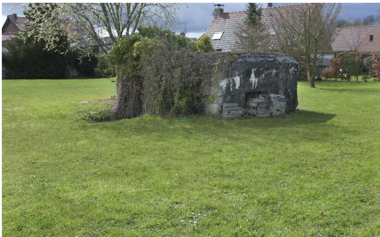
Vue générale, vers le sud
