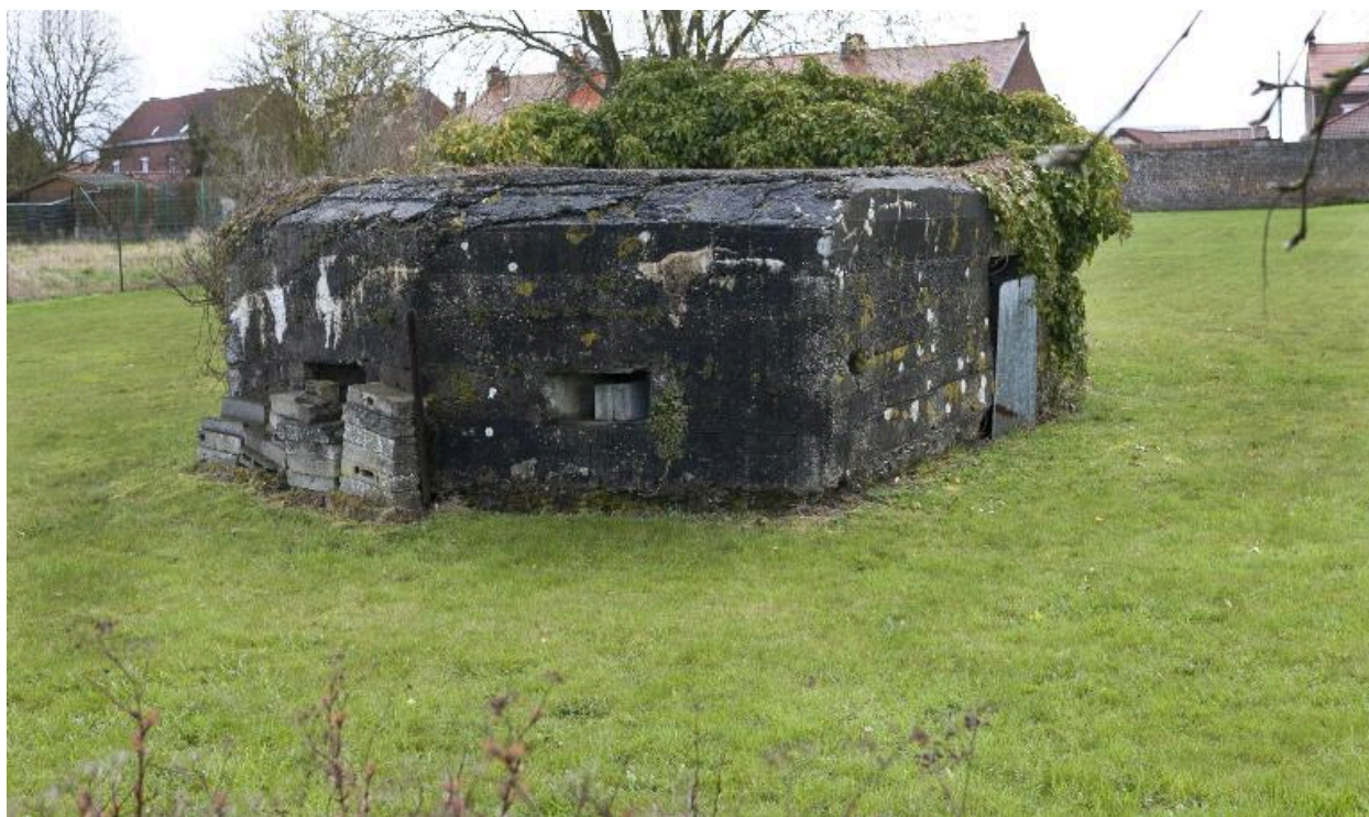
Vue générale, vers l'est
