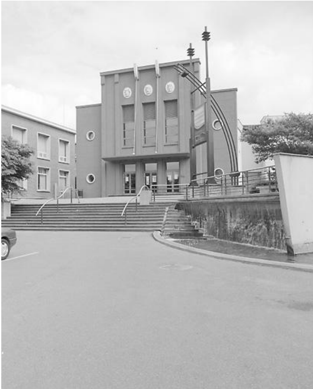
Salle des fêtes construite en 1954.
