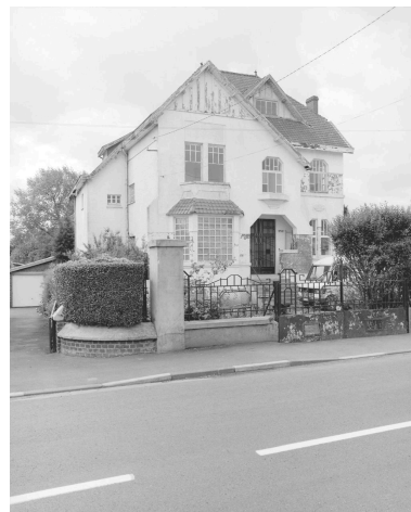
Maison sise au n°94 de la rue de la République construite par l'architecte Lafitte. Phot. Thierry Petitberghien IVR31_20025902044X
