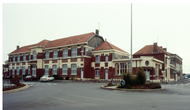
Vue de l'ensemble école, poste et bains-douches, construit par Adolphe Danis en 1928. Phot. Sophie Luchier IVR31_19955901123ZA
