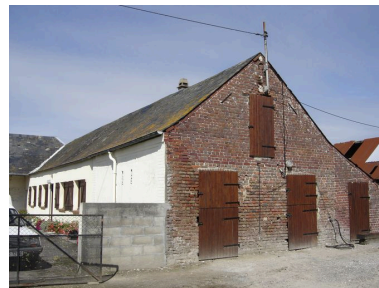
Vue latérale du logis avec bâtiments agricoles dans le prolongement. Phot. Inès Guérin IVR22_20078005336NUCA
