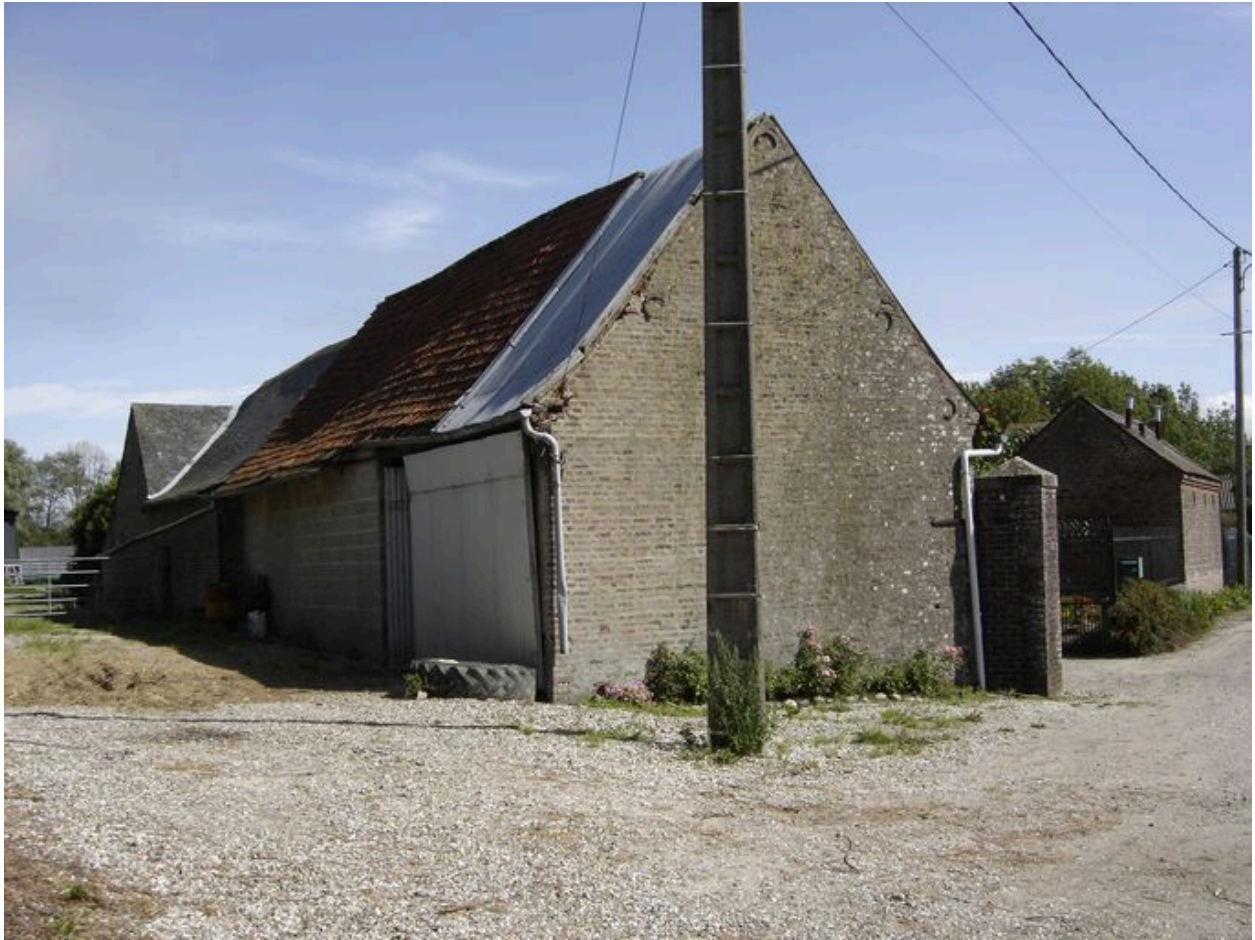
Vue postérieure des bâtiments en enfilade situés perpendiculairement à la rue.
