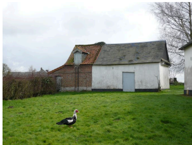
Vue des dépendances. Phot. Inès Guérin IVR22_20078005610NUCA
