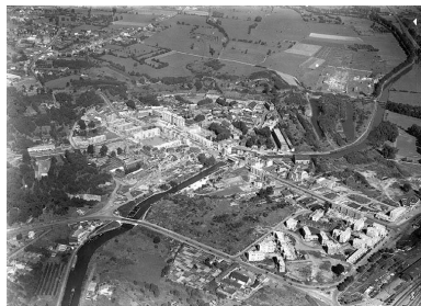
Vue aérienne de la ville de Maubeuge, [ca 1950] (AC Maubeuge).
