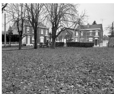
Cité de la centrale électrique de Maubeuge.
