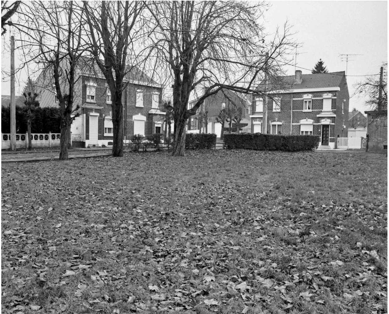
Cité de la centrale électrique de Maubeuge.
