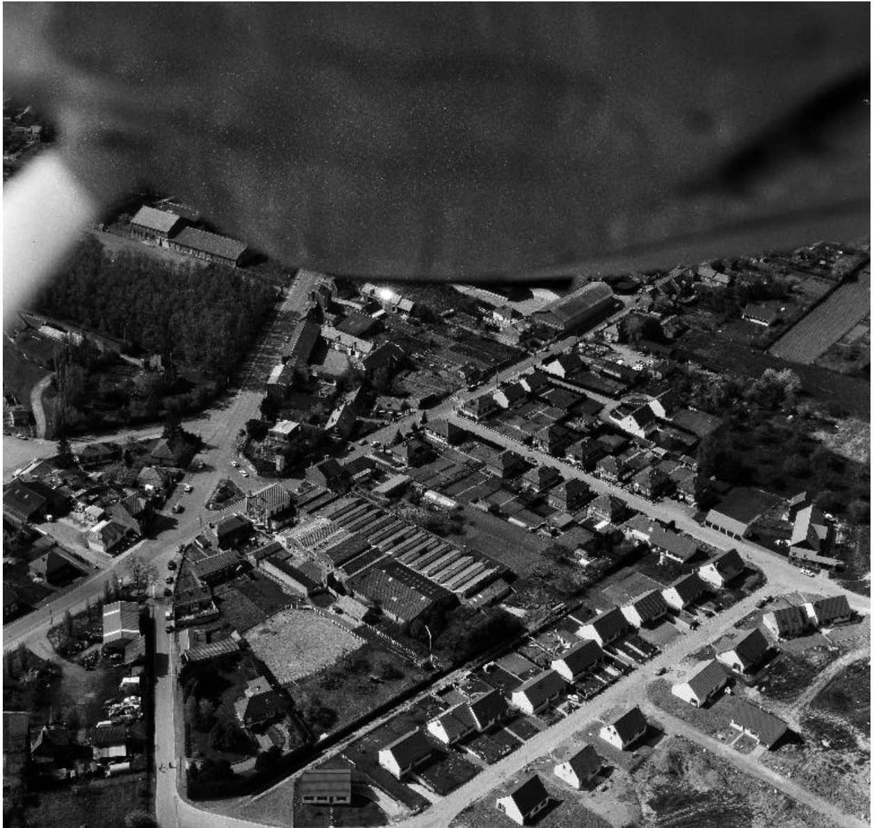
Vue aérienne, flanc est.
