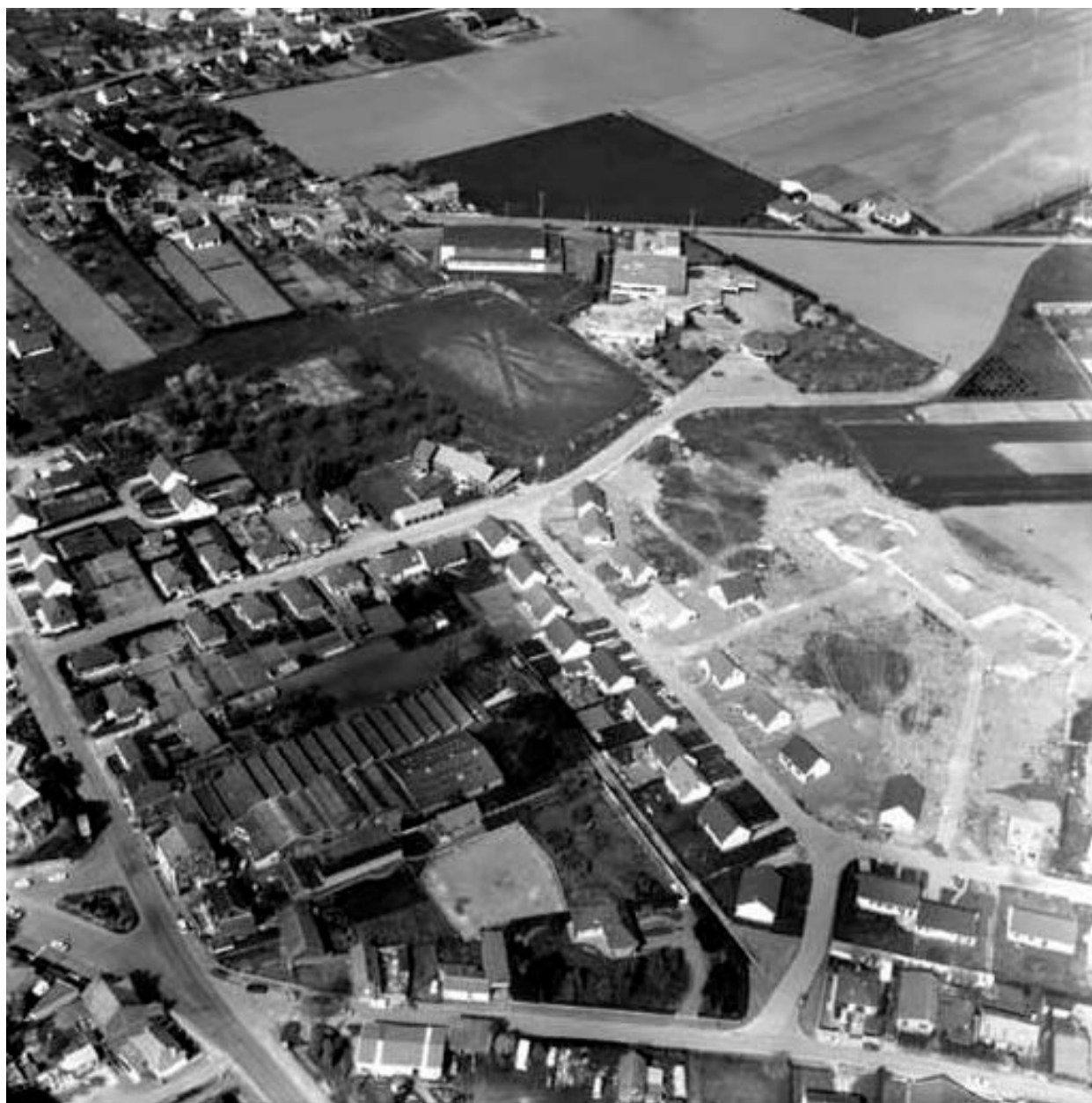
Vue aérienne, flanc sud-ouest.
