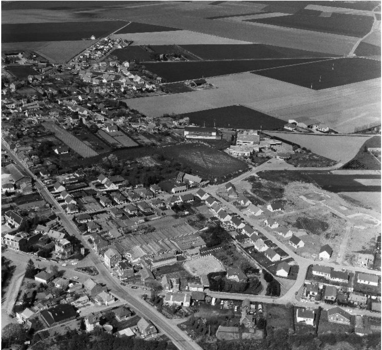
Vue aérienne, flanc sud-ouest.
