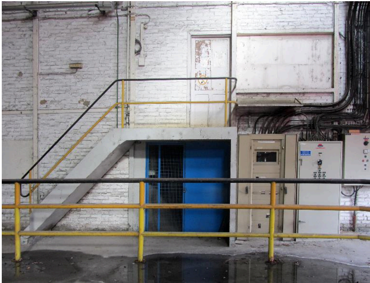
Détail de l'accès aux vestiaires depuis l'atelier de fabrication.
