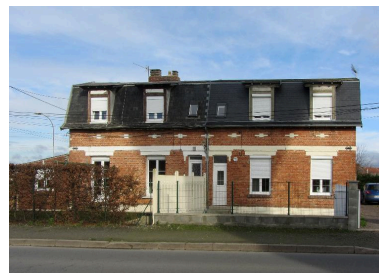
Maison à deux unités d'habitation de la cité Sébastopol, vue de face. Phot. Bertrand Fournier IVR32_20168005023NUCA
