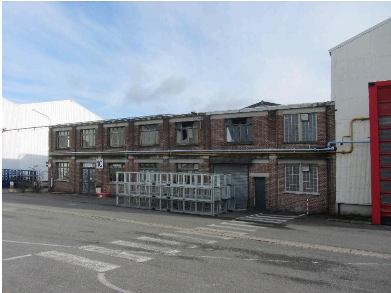
Vue d'ensemble de l'atelier de maintenance.
