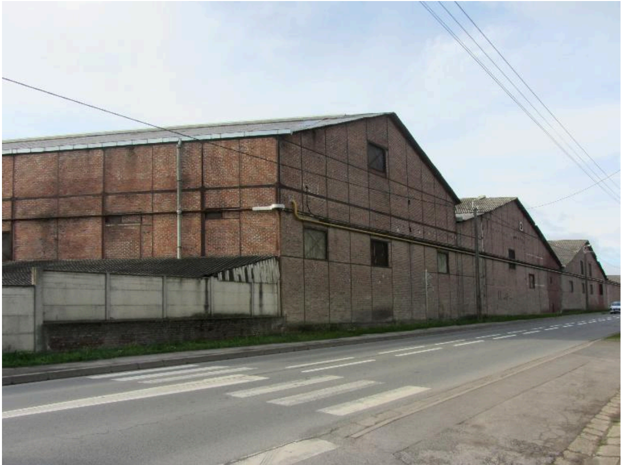
Pignons sur rue des ateliers de fabrication.
