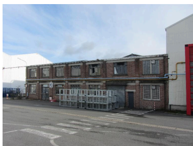
Vue d'ensemble de l'atelier de maintenance. Phot. Bertrand Fournier IVR32_20168005017NUCA
