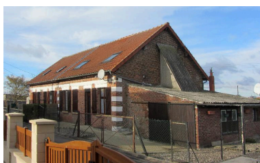
Maisons ouvrière de la cité Sébastienopol, vue d'ensemble. Phot. Bertrand Fournier IVR32_20168005025NUCA
