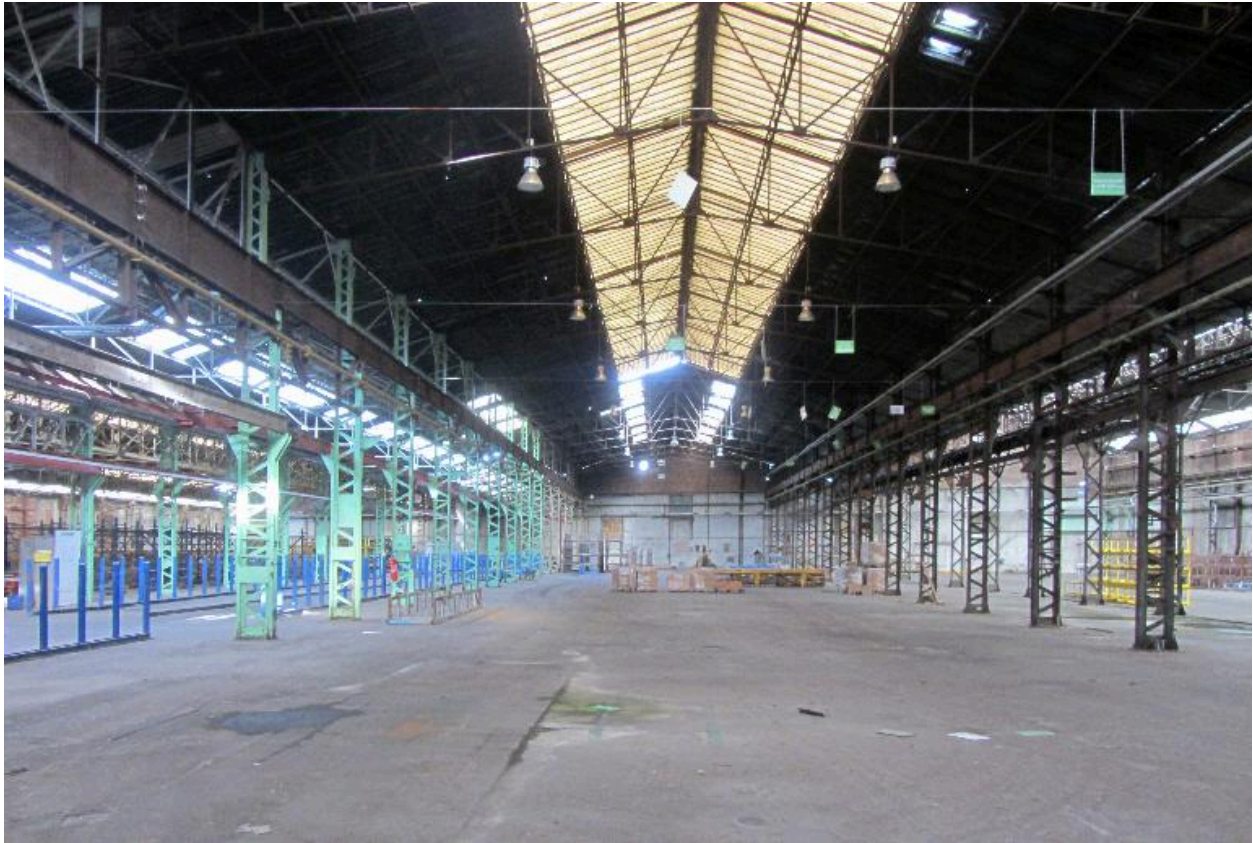
Vue intérieure d'une des halles de fabrication.
