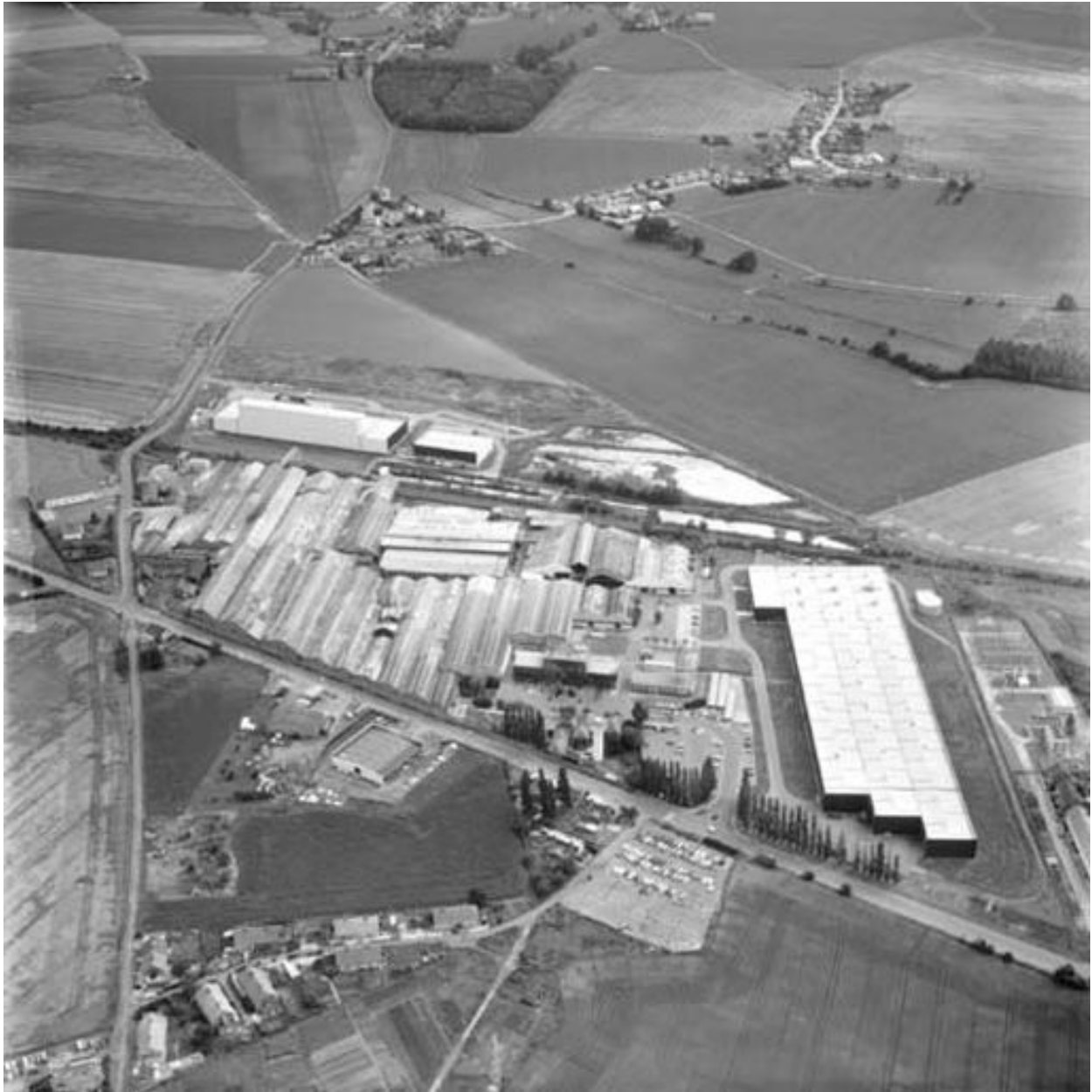
Vue aérienne, flanc nord.
