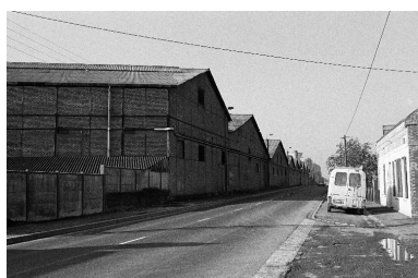
Les anciens ateliers en pan de fer et brique, vue des pignons sur rue. Phot. Francis Dubuc IVR22_19908001330Z
