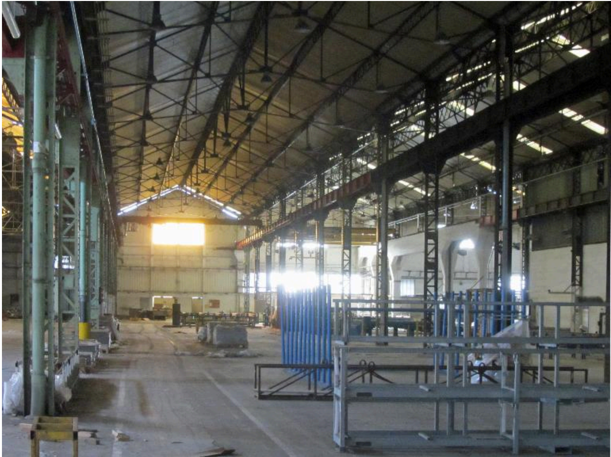
Vue intérieure de la seconde halle de fabrication.
