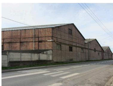
Pignons sur rue des ateliers de fabrication. Phot. Bertrand Fournier IVR32_20168005009NUCA
