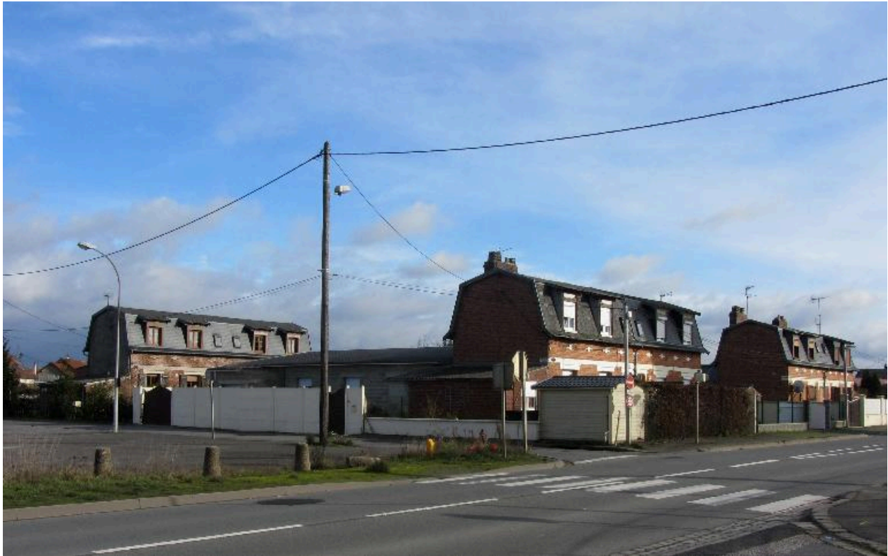
Ensemble de maisons à deux unités d'habitation de la Cité Sébastopol.
