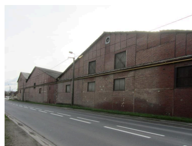
Détail des pignons sur rue des ateliers de fabrication. Phot. Bertrand Fournier IVR32_20168005010NUCA
