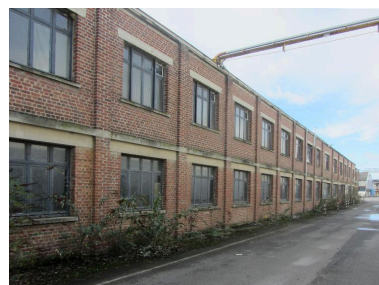
Façade longitudinale de l'atelier de maintenance. Phot. Bertrand Fournier IVR32_20168005018NUCA
