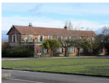
Façade postérieure des logements directement attenant à l'usine. Phot. Bertrand Fournier IVR32_20168005020NUCA
