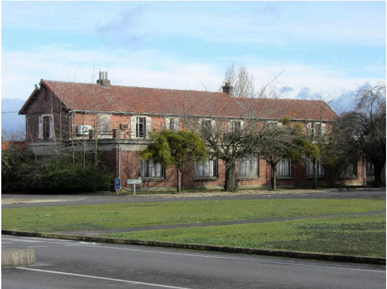
Façade postérieure des logements directement attenants à l'usine.
