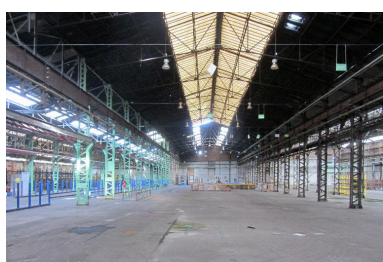
Vue intérieure d'une des halles de fabrication. Phot. Bertrand Fournier IVR32_20168005014NUCA
