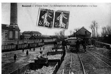
Déchargement de craies phosphatées en gare de Beauval vers 1900 (AD Oise ; fonds Ecomusée du Beauvaisis). Phot. Thierry Lefébure IVR22_20098000148NUCA
