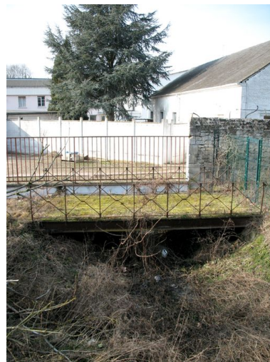
Pont sur la Brèche à l'entrée de l'usine, témoin du passage de la rivière au coeur du site. Phot. Clarisse Lorieux IVR22_20096005041NUCA
