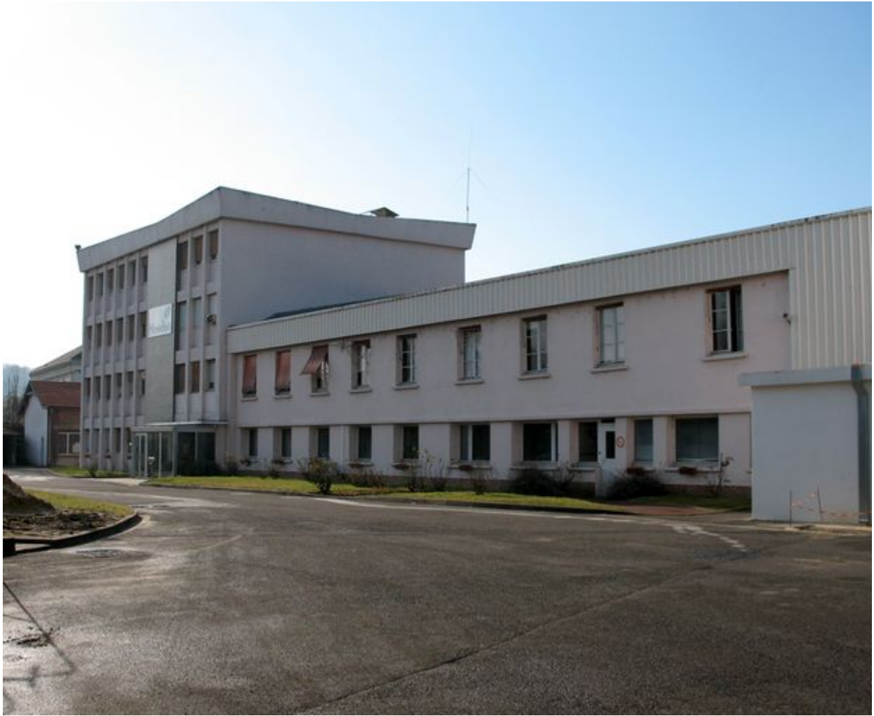
Le bâtiment des bureaux (2009).
