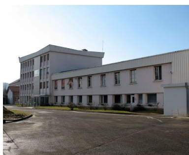
Le bâtiment des bureaux (2009). Phot. Clarisse Lorieux IVR22_20096005005NUCA
