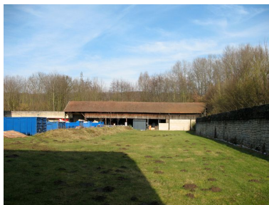
Le hangar de sablage et le mur de clôture en pierre (2009). Phot. Clarisse Lorieux IVR22_20096005007NUCA
