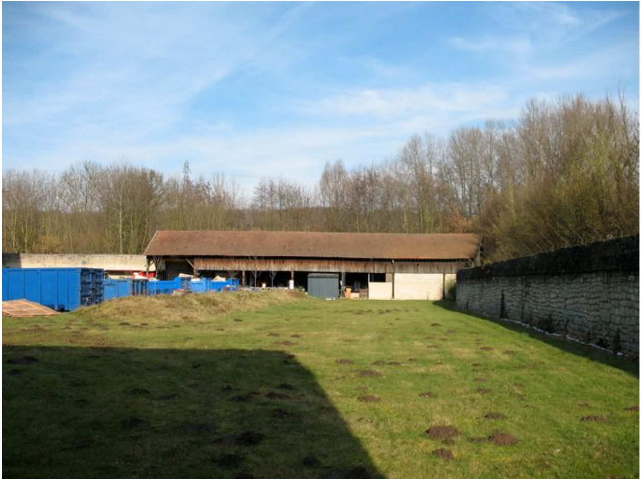
Le hangar de sablage et le mur de clôture en pierre (2009).
