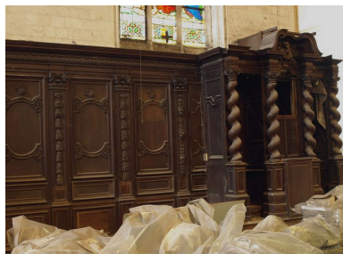
Vue générale, bas-côté nord Phot. Bruno Decrock IVR31_20106202083NUCA
