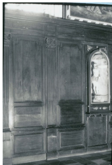
Vue de détail, bas-côté sud (phot. Wintrebert, 1978, fonds AOA62) Phot. Julien Marasi IVR31_20106202217NUC
