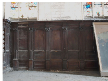
Vue partielle, bas-côté sud Phot. Julien Marasi IVR31_20106202087NUCA
