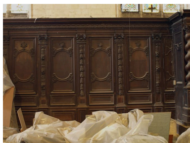
Vue partielle, bas-côté nord Phot. Bruno Decrock IVR31_20106202084NUCA
