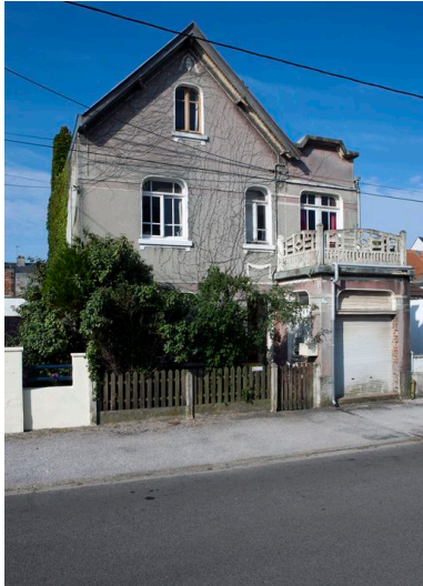
Vue générale. Phot. Pierre Thibaut IVR31_20146202220NUCA
