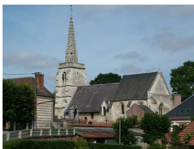
Vue de situation depuis le sud. Phot. Frédéric Fournis IVR22_20098005282NUCA
