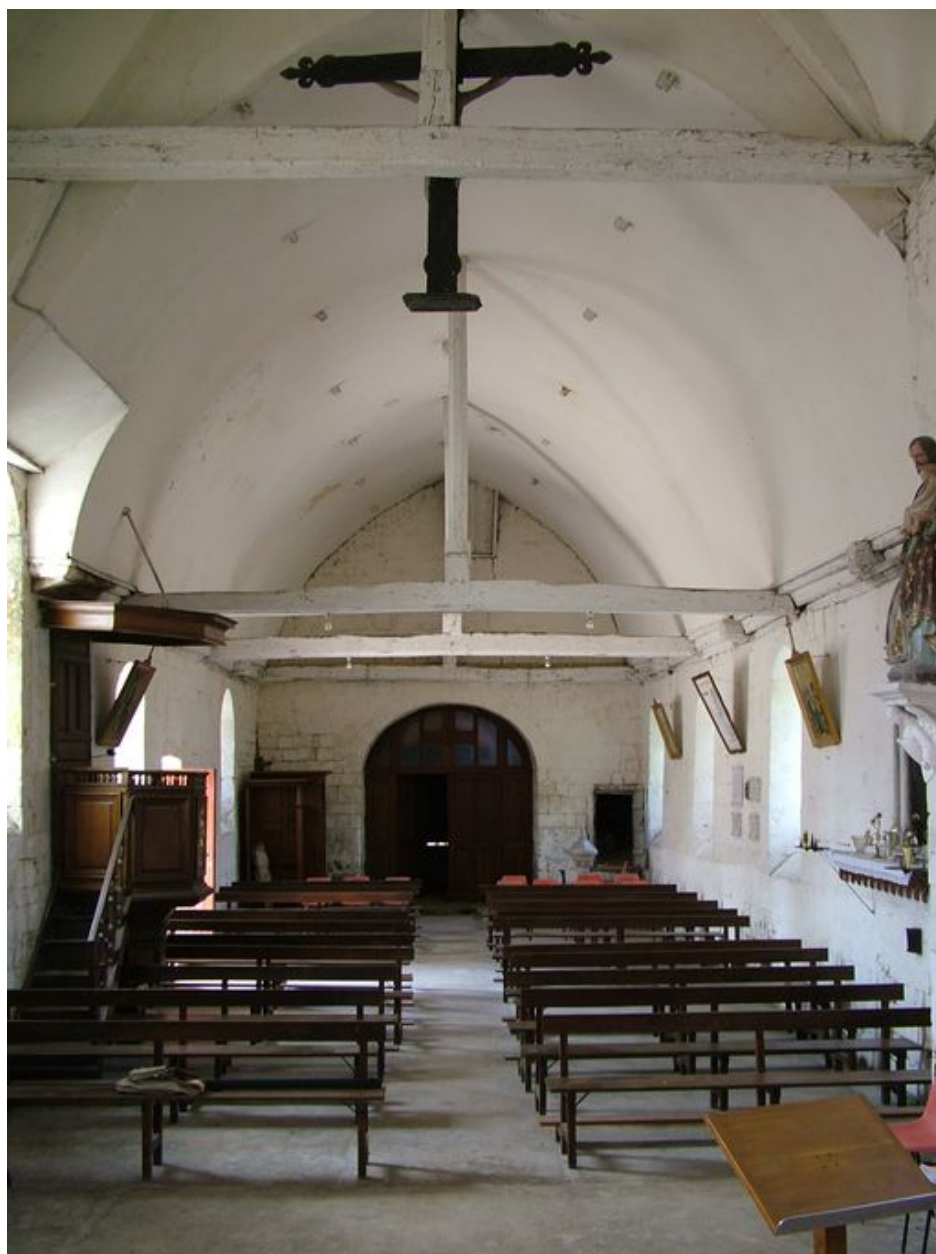
Vue intérieure de la nef depuis le chœur.
