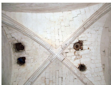
Voûte d'ogives du clocher-porche. Phot. Frédéric Fournis IVR22_20098005275NUCA
