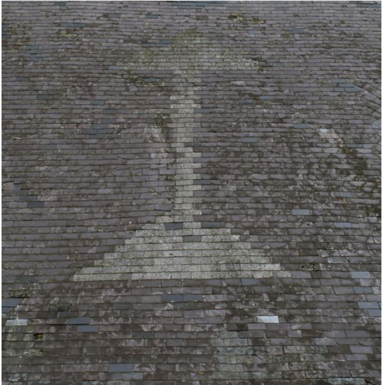
Détail d'un motif dessiné en ardoise sur le toit de la nef.
