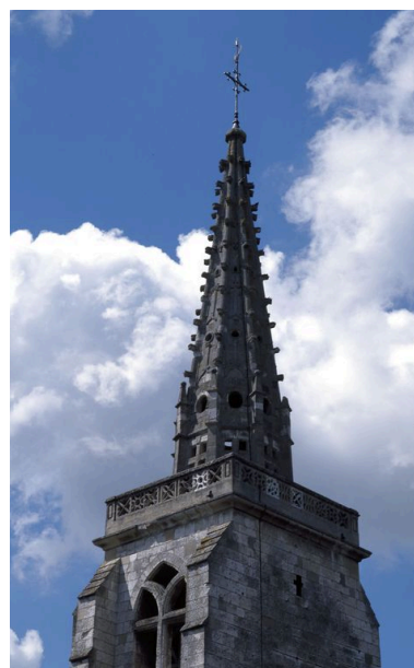
Flèche du clocher. Phot. Marie-Laure Monnehay-Vulliet IVR22_20098000156XA
