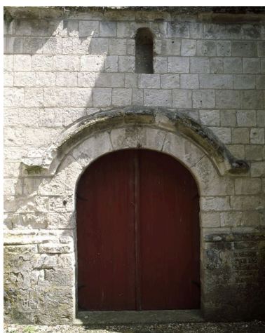
Portail occidental. Phot. Marie-Laure Monnehay-Vulliet IVR22_20098000159XA
