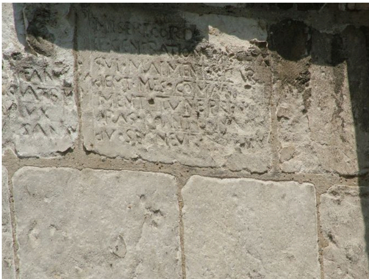
Graffitis sur le mur extérieur du clocher, 17e ou 18e siècle.
