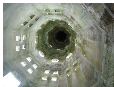
Intrados de la flèche du clocher. Phot. Frédéric Fournis IVR22_20098005272NUCA
