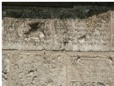
Graffitis sur le mur extérieur du clocher, 17 ou 18e siècle. Phot. Frédéric Fournis IVR22_20098005269NUCA
