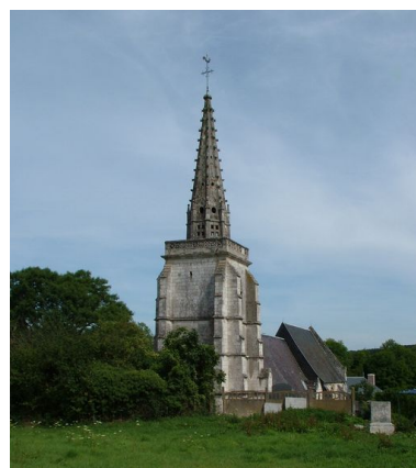
Vue de situation depuis l'ouest. Phot. Frédéric Fournis IVR22_20098005284NUCA
