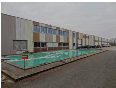
Nouvelle usine située au sud de village rue Jean Moulin.
