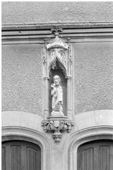
Niche ornant la façade. Phot. Thierry Lefébure IVR22_19940201200X
