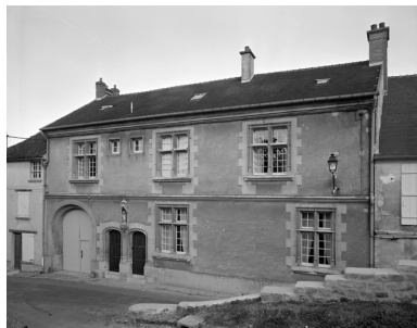
Vue générale depuis la rampe d'accès au château. Phot. Thierry Lefébure IVR22_19940201136V
