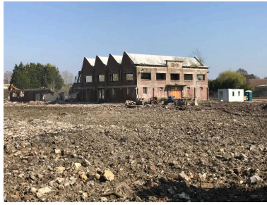
L'atelier de confection en cours de destruction, mars 2017.
