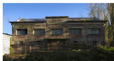
Entrepôt des matières premières et atelier de confection, vue depuis l'ouest avec le quai de déchargement. Phot. Thierry Lefébure IVR32_20168000805NUC2AQ
