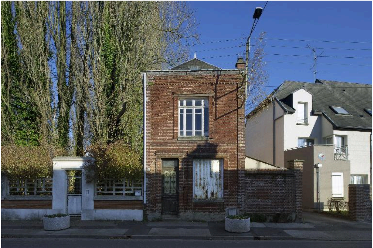
Façade sur rue du logement de concierge.
