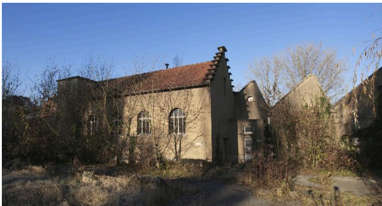
Le transformateur électrique, vue générale depuis le sud-est.
