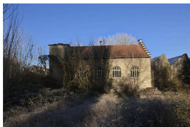
Façade latérale sud du transformateur électrique. Phot. Thierry Lefébure IVR32_20168000804NUC2A
