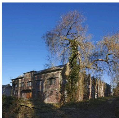
Entrepôt des matières premières et atelier de confection, vue depuis le sud-ouest. Phot. Thierry Lefébure IVR32_20168000807NUC2AQ
