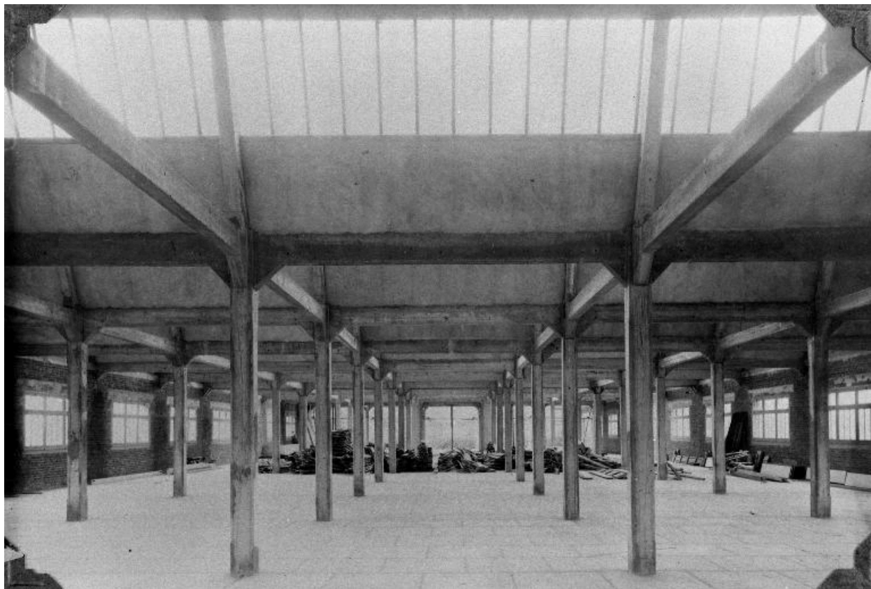
Intérieur de l'atelier de fabrication, dit atelier n°2, vue vers le sud, avant la mise en place des machines, mars 1947 (archives privées de l'entreprise).
