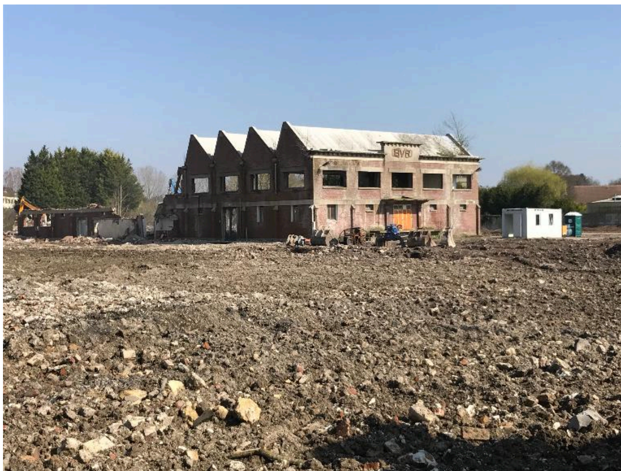
L'atelier de confection en cours de destruction, mars 2017.
