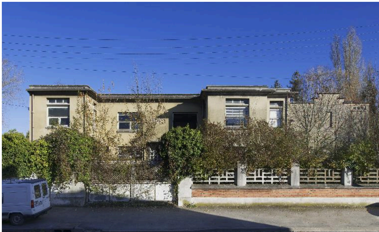
Façade sur rue (ouest) des bureaux.
