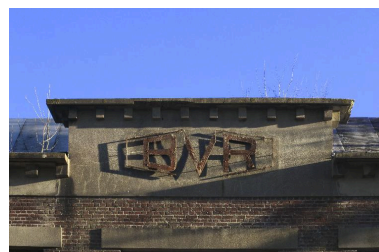
Détail de l'enseigne de l'entreprise au sommet de l'atelier de confection. Phot. Thierry Lefébure IVR32_20168000806NUC2A
