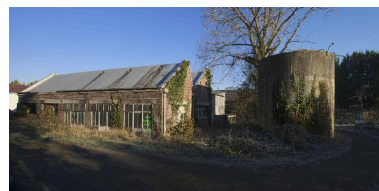
Vue générale de l'atelier de menuiserie et du réservoir d'eau. Phot. Thierry Lefébure IVR32_20168000815NUC2AQ
