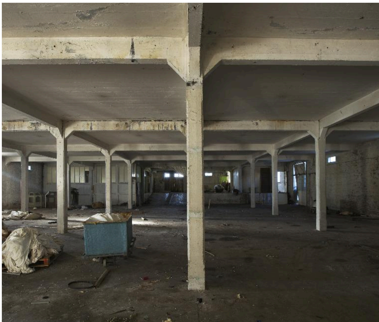
Intérieur de l'entrepôt des matières premières.
