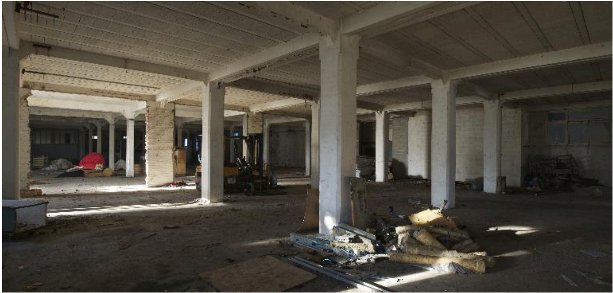
Intérieur de l'entrepôt aux matières premières.
