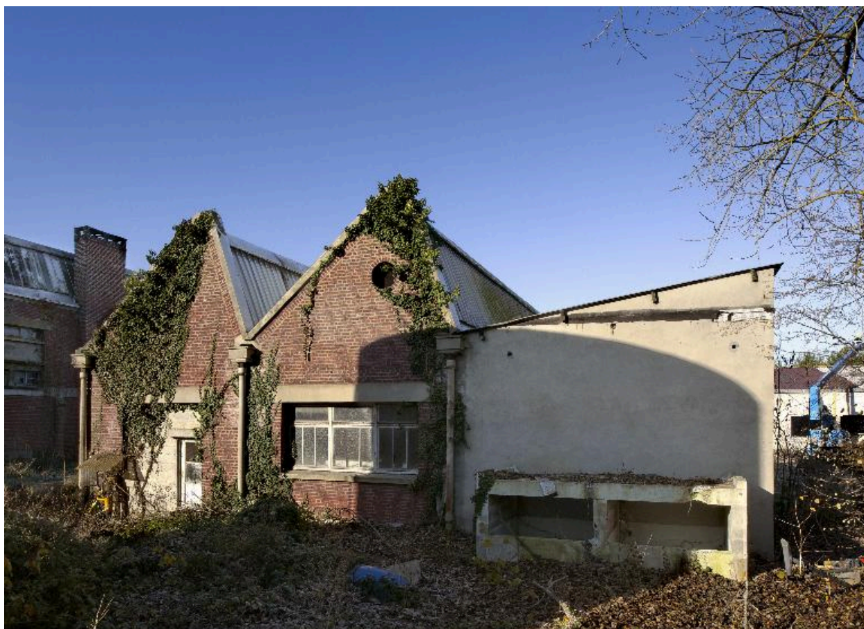
L'atelier de menuiserie, façade sud.
