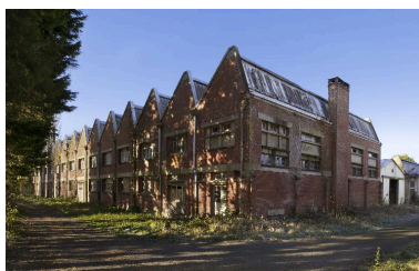
Entrepôt de matières premières et atelier de confection, vue depuis l'est. Phot. Thierry Lefébure IVR32_20168000808NUC2AQ
