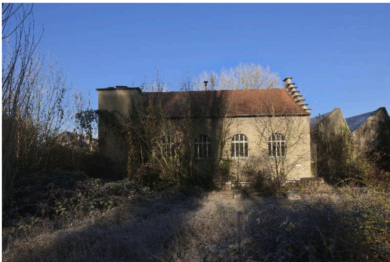
Façade latérale sud du transformateur électrique.
