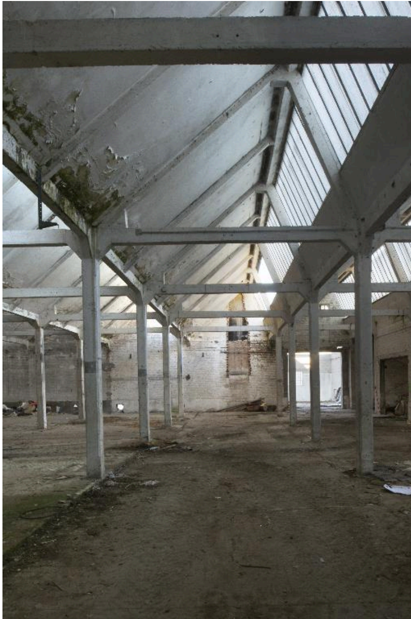
Détail d'une travée en shed de l'atelier de tissage.
