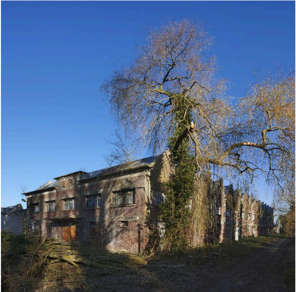
Entrepôt des matières premières et atelier de confection, vue depuis le sud-ouest.
