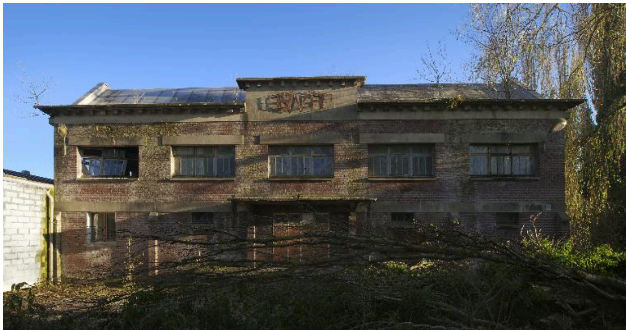
Entrepôt des matières premières et atelier de confection, vue depuis l'ouest avec le quai de déchargement.
