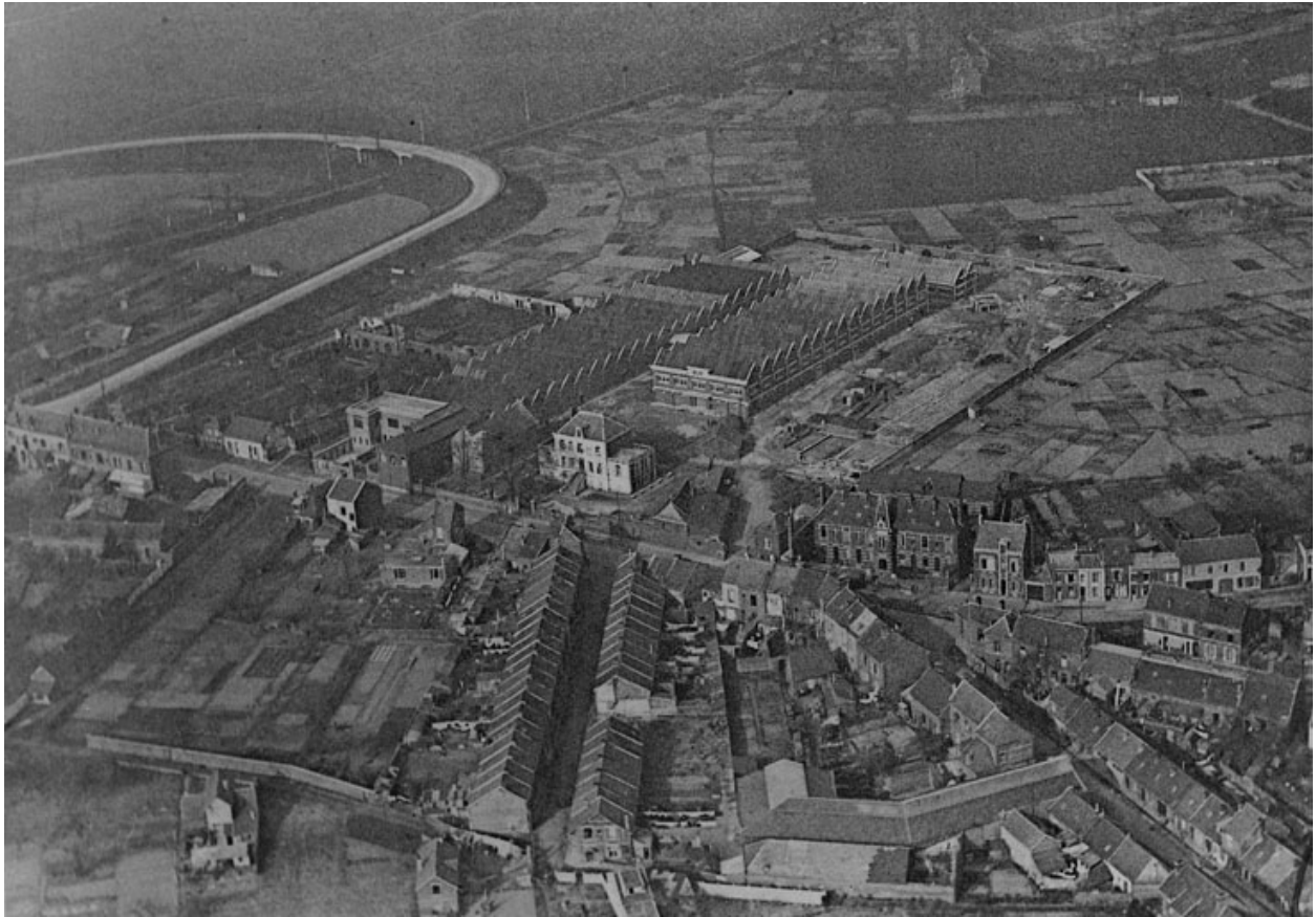
Vue aérienne du site, mars 1948. Extrait de : La vie de la maison 1946-1948", cahier n° 2 (archives privées de l'entreprise).
