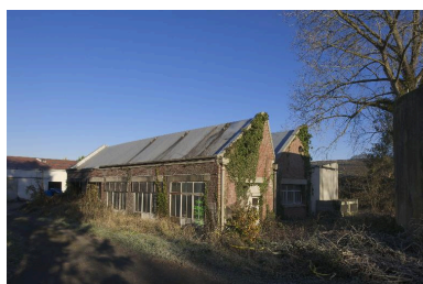
Vue générale de l'atelier de menuiserie. Phot. Thierry Lefébure IVR32_20168000816NUC2A
