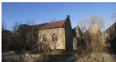
Le transformateur électrique, vue générale depuis le sud-est. Phot. Thierry Lefébure IVR32_20168000803NUC2A
