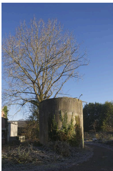
Le réservoir d'eau. Phot. Thierry Lefébure IVR32_20168000817NUC2A
