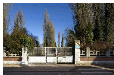
Le portail d'entrée principal de l'usine. Phot. Thierry Lefébure IVR32_20168000824NUC2A
