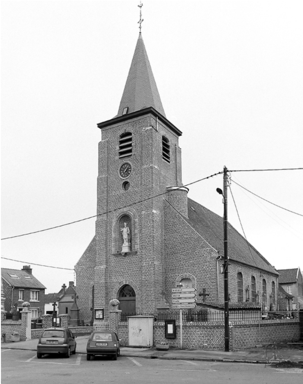
Vue générale de trois quarts (avant rénovation, en 2004).
