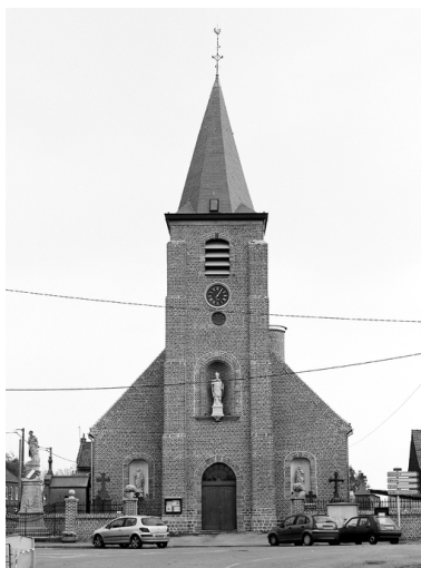
Vue générale de face (avant rénovation, en 2004). Phot. Philippe Dapvril IVR31_20045900655X
