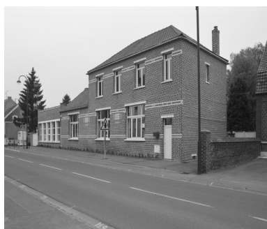
Vue générale de l'école depuis la rue. Phot. Philippe Dapvril IVR31_20085901102X
