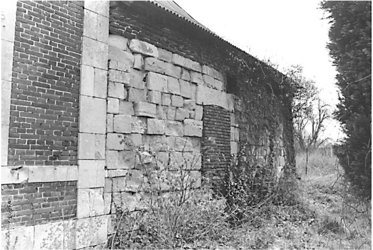
Elévation antérieure de l'ancien logis datant du 18e siècle.
