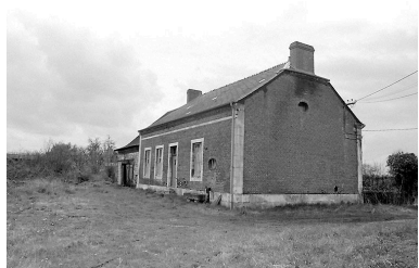
Élévation postérieure du logis construit au milieu du 19e siècle. Phot. Xavier-Philippe Guiochon IVR22_19980200822Z
