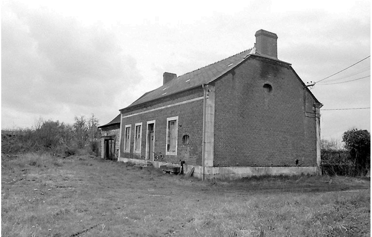
Elévation postérieure du logis construit au milieu du 19e siècle.
