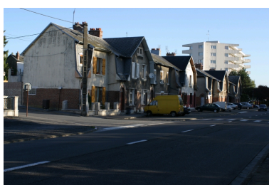
De gauche à droite, les logements ouvriers de types A, B (en ressaut), C (entre les deux ressauts) et D (à l'angle du deuxième groupe). Phot. Frédéric Pillet IVR22_20040201196NUCA
