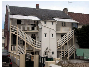
Elévation postérieure. Phot. Elisabeth Justome IVR22_20058003922NUCA
