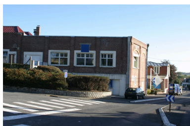
L'usine à l'angle des rues Henri- Dunant et Louise-Michel. Phot. Frédéric Pillet IVR22_20040201175NUCA
