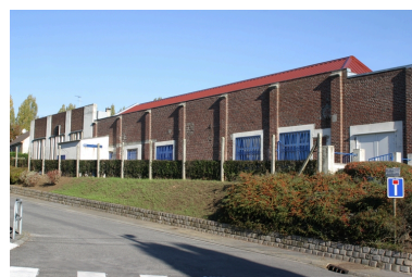
Les anciens ateliers : les sheds sont aujourd'hui entièrement couverts de tôles nervurées. Phot. Frédéric Pillet IVR22_20040201191NUCA
