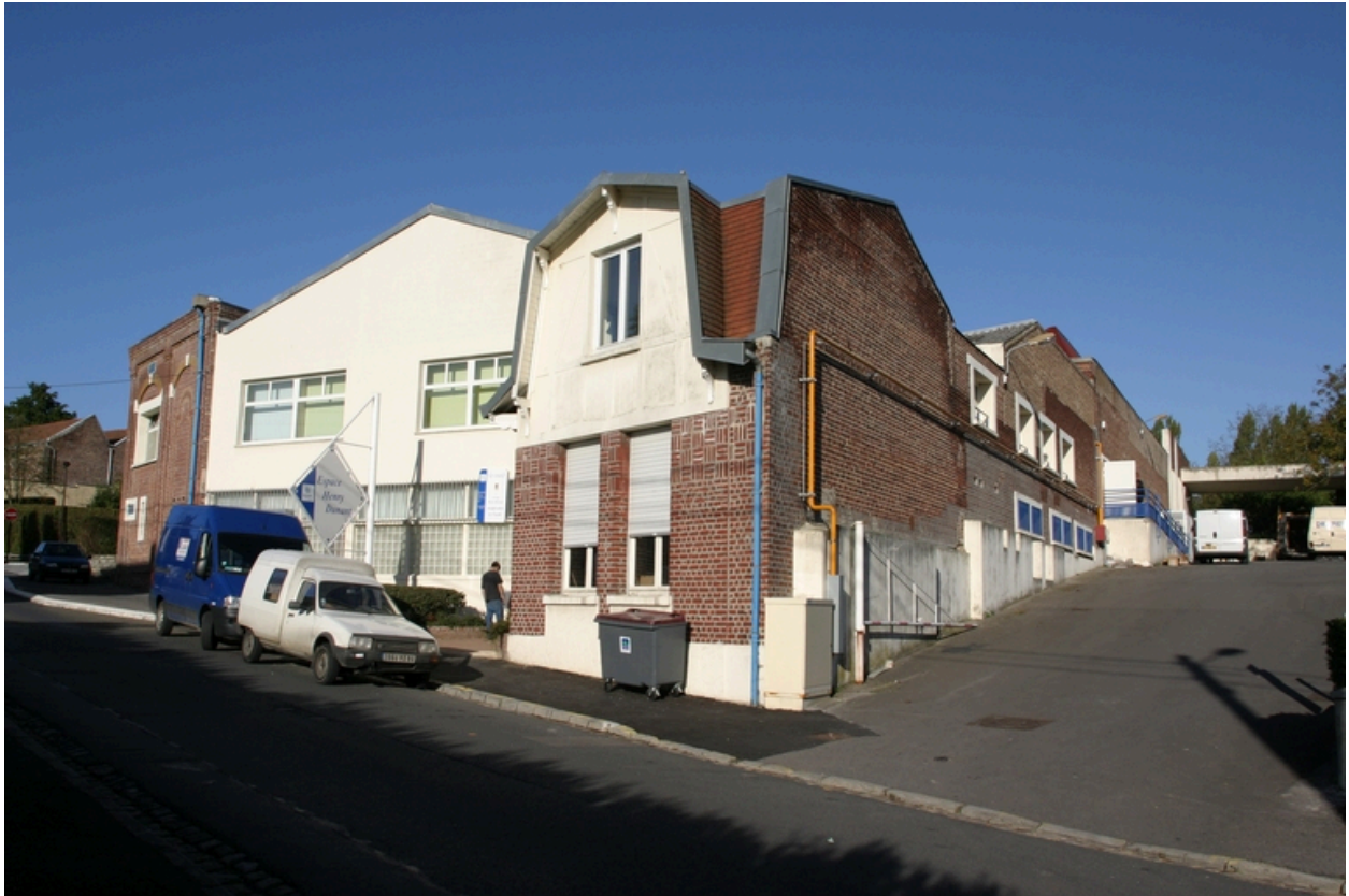
Vue générale de l'usine.
