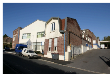
Vue générale de l'usine. Phot. Frédéric Pillet IVR22_20040201174NUCA
