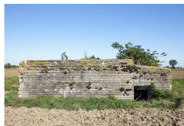
Vue latérale, vers le nord-est Phot. Pierre Thibaut IVR31_20155901676NUCA
