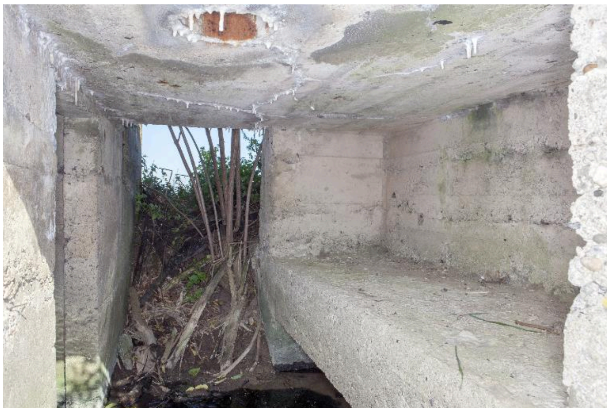
Intérieur du porche pare-souffle
