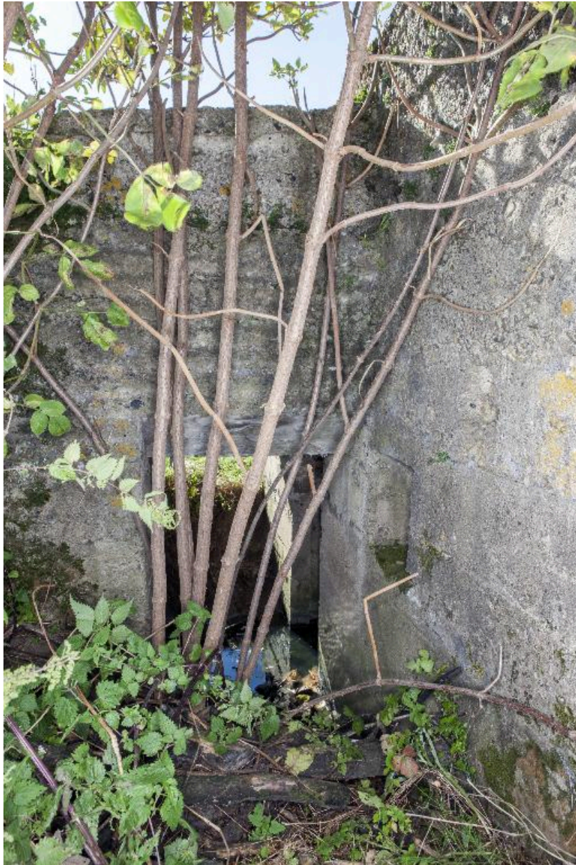
Entrée sud-ouest du porche pare-souffle
