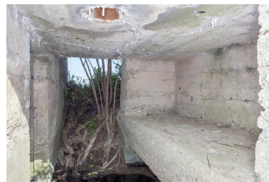
Intérieur du porche pare-souffle Phot. Pierre Thibaut IVR31_20155901679NUCA
