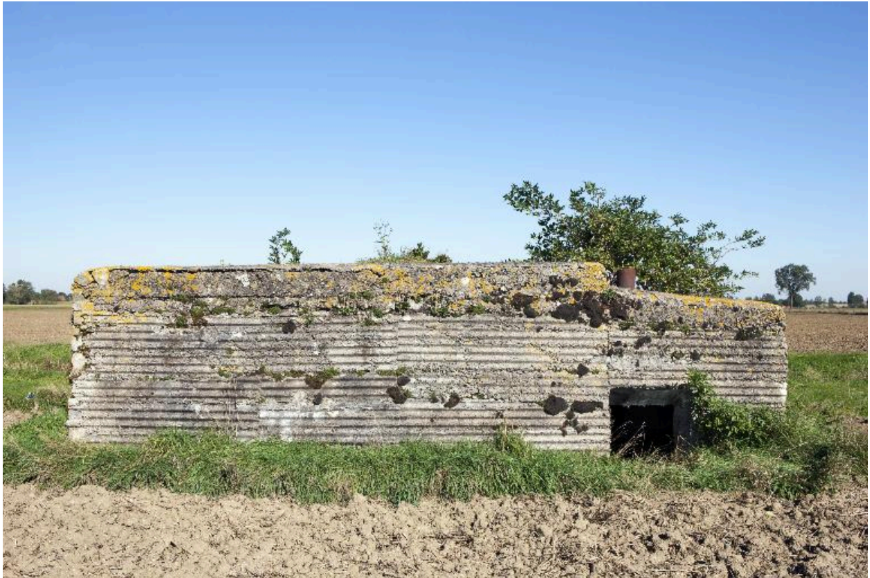
Vue latérale, vers le nord-est
