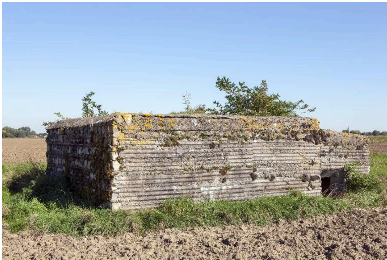
Vue de trois-quarts arrière, vers l'est
