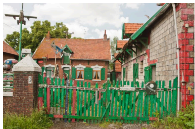
Vue partielle des bâtiments de ferme.
