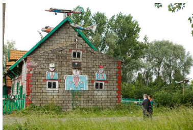
Vue partielle des bâtiments de ferme.
