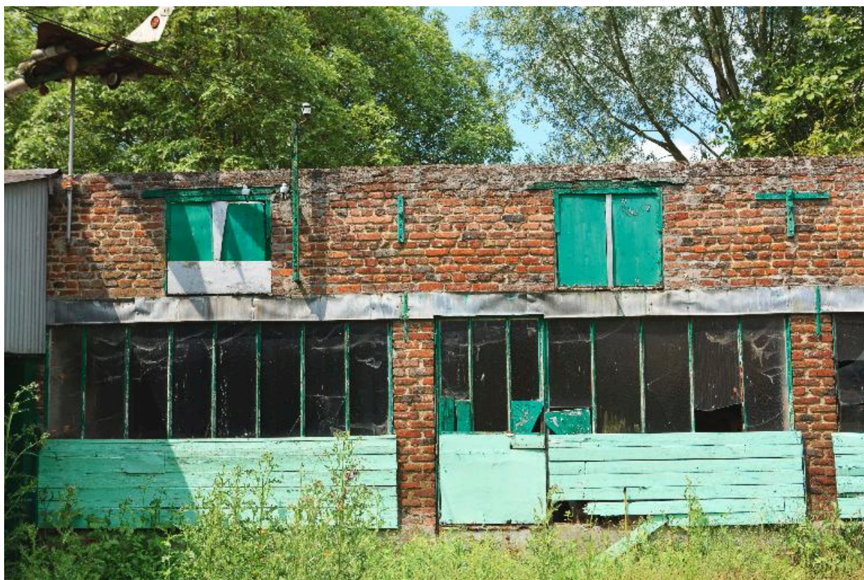
Vue partielle de bâtiment servant d'atelier.
