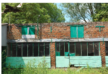
Vue partielle de bâtiment servant d'atelier. Phot. Hubert Bouvet IVR31_20135901558NUC4A
