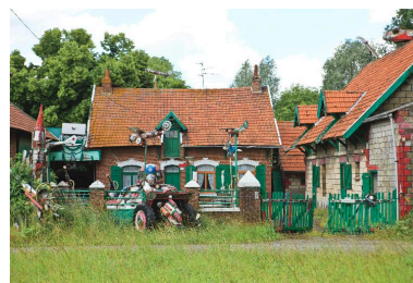
Vue générale des bâtiments de ferme.
