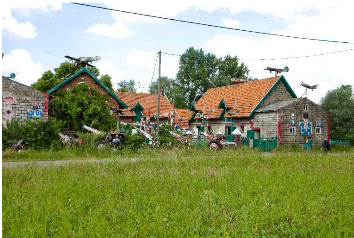
Vue générale des bâtiments de ferme.
