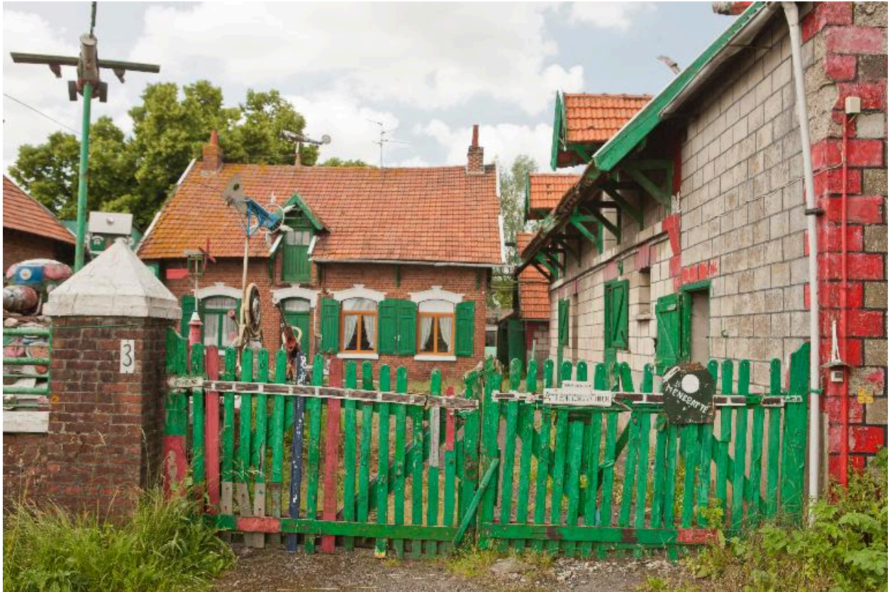
Vue partielle des bâtiments de ferme.
