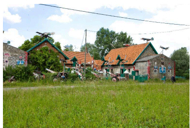
Vue générale des bâtiments de ferme.
