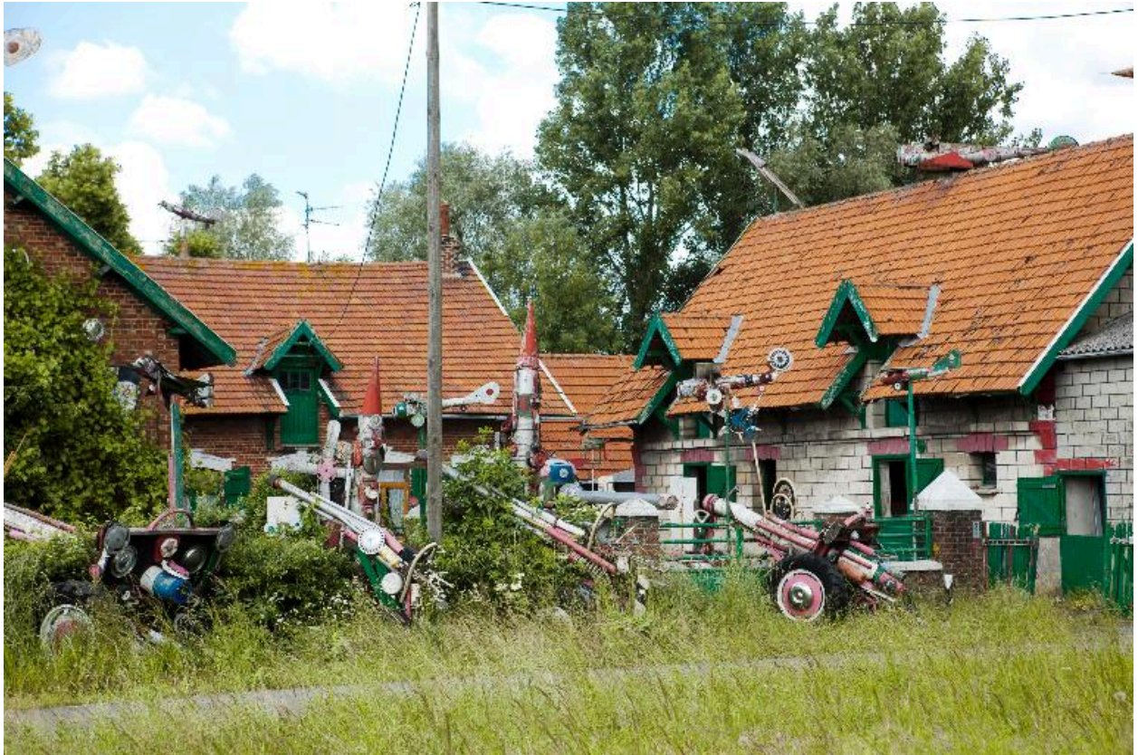
Vue générale des bâtiments de ferme.
