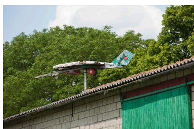
Avion sur le toit du bâtiment annexe de la grange. Phot. Hubert Bouvet IVR31_20135901597NUC4A
