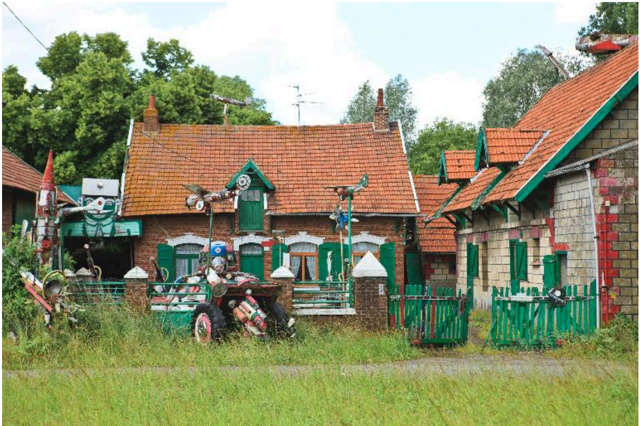
Vue générale des bâtiments de ferme.
