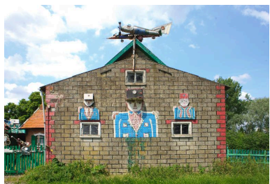
Vue partielle des bâtiments de ferme : l'ancienne porcherie.
