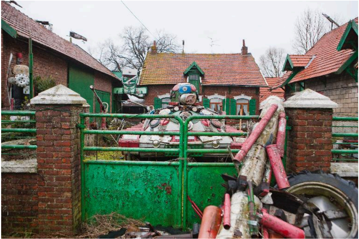
Vue partielle des bâtiments de ferme en janvier 2014.
