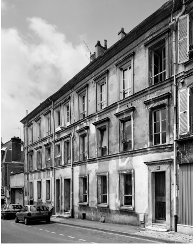
Vue de la façade sur rue. Phot. Thierry Lefébure IVR22_19960201109V
