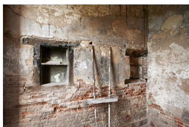
Rez-de-chaussée. Réduit du logis du XVIe siècle.
