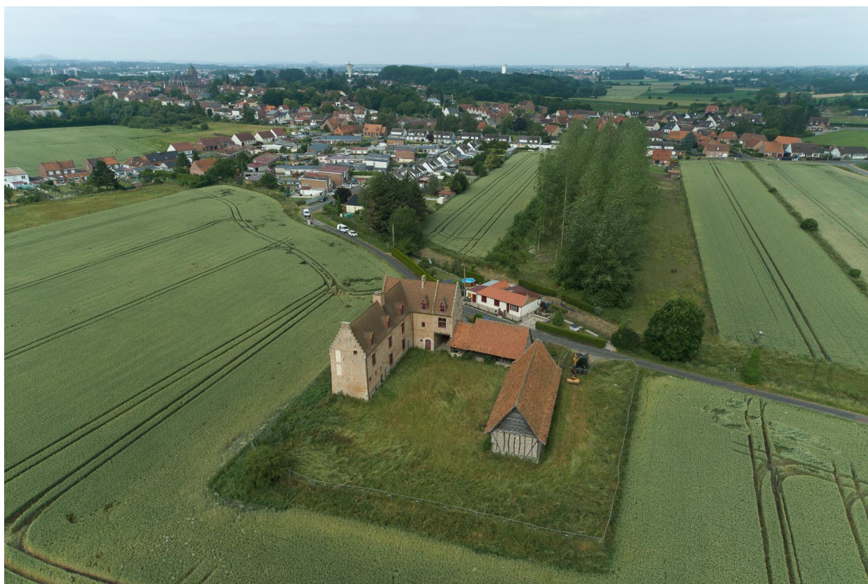
Vue aérienne depuis l'est.
