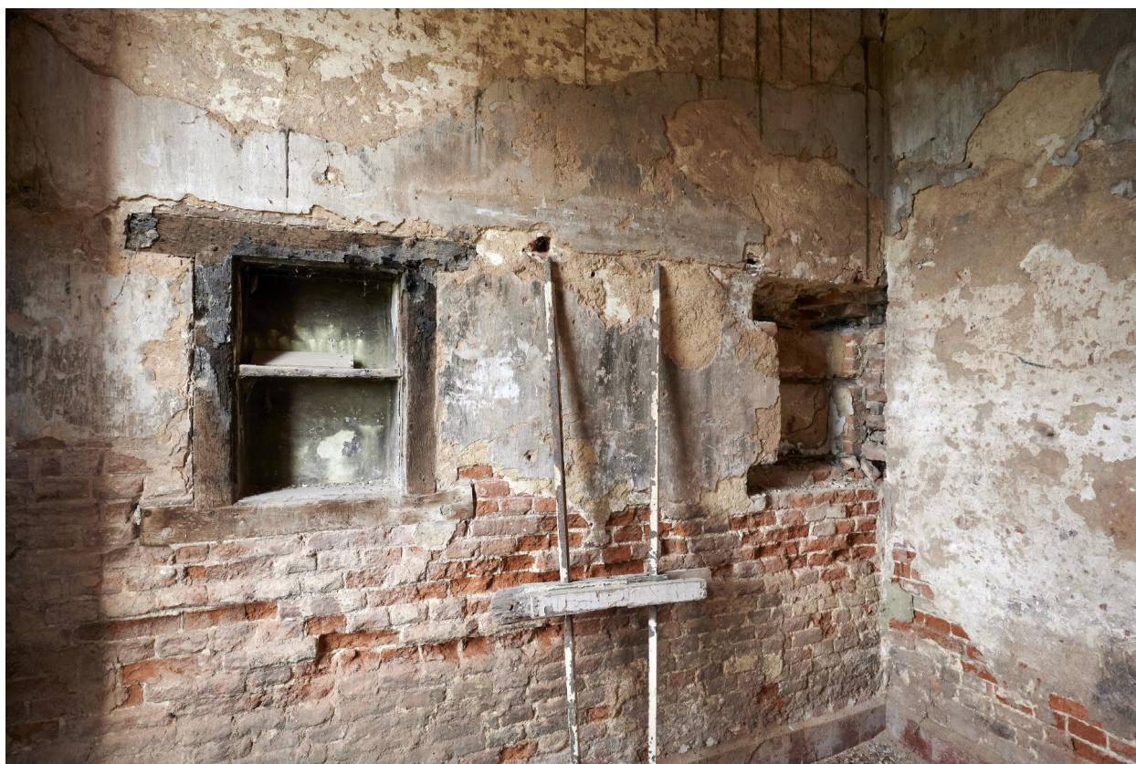
Rez-de-chaussée. Réduit du logis du XVIe siècle.
