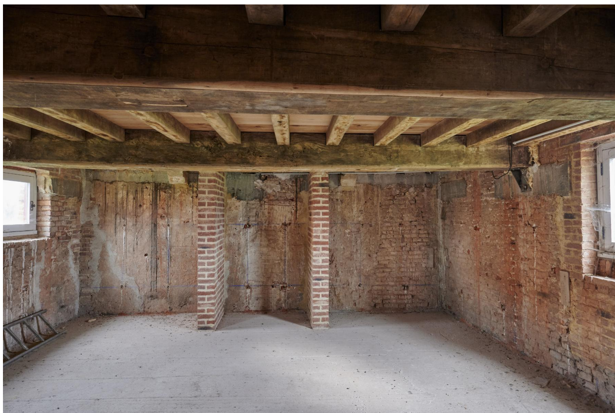
Rez-de-chaussée. Logis du XVIIe siècle. Arrière-cuisine.
