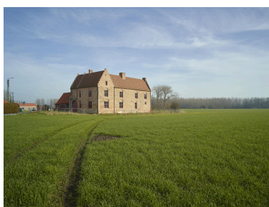
Vue environnante du manoir depuis la rue du manoir de l'Estracelles, en arrivant par le sud-ouest. Phot. Pierre Thibaut IVR32_20236200111NUCA
