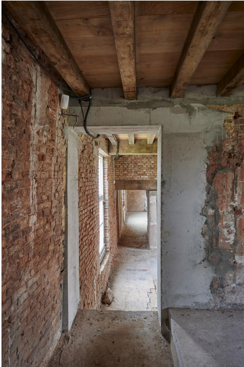
Rez-de-chaussée. Logis du XVIIe siècle. Vue en enfilade de l'espace de circulation depuis l'arrière-cuisine.
