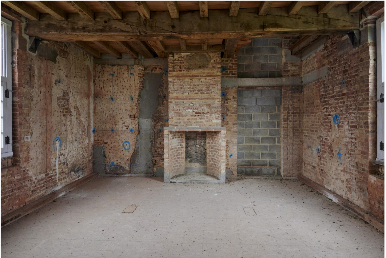
Premier étage. Logis du XVII e siècle. Dernière salle à l'est du bâtiment. Âtre de cheminée originel. Accès vers les combles.
