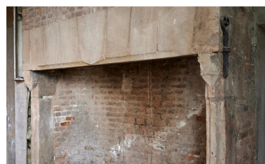
Rez-de-chaussée. Logis du XVIIe siècle. Détail de la cheminée de la salle principale. Phot. Pierre Thibaut IVR32_20236200127NUCA
