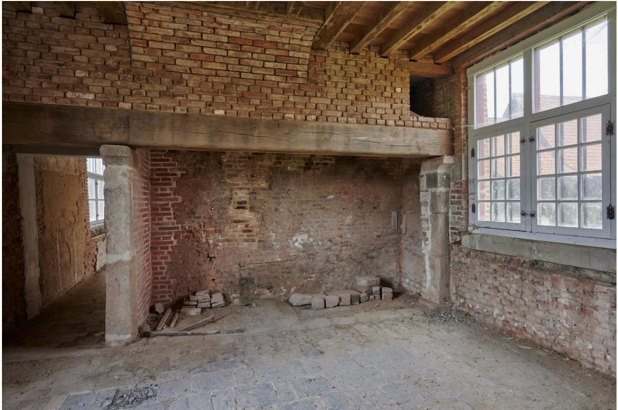
Rez-de-chaussée. Logis du XVIIe siècle. Cuisine et cheminée monumentale.
