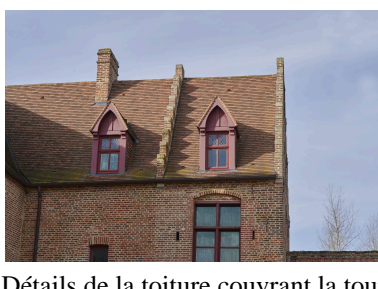
Détails de la toiture couvrant la tour porche et le logis du XVIe siècle. Phot. Pierre Thibaut IVR32_20236200157NUCA
