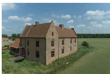
Vue aérienne depuis le sud-ouest. Phot. Marc Kérignard IVR32_20236200580NUCA
