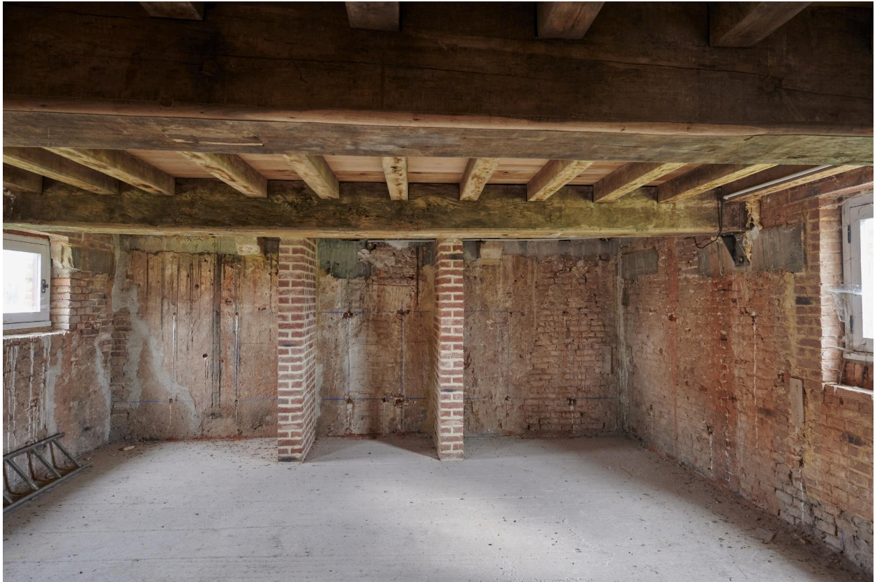
Rez-de-chaussée. Logis du XVIIe siècle. Arrière-cuisine.
