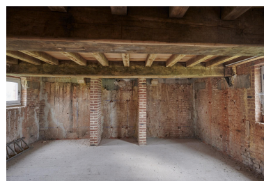
Rez-de-chaussée. Logis du XVIIe siècle. Arrière-cuisine. Phot. Pierre Thibaut IVR32_20236200143NUCA
