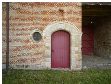
Porte d'accès au logis du XVIe siècle. Vue prise depuis la cour intérieure. Phot. Pierre Thibaut IVR32_20236200116NUCA
