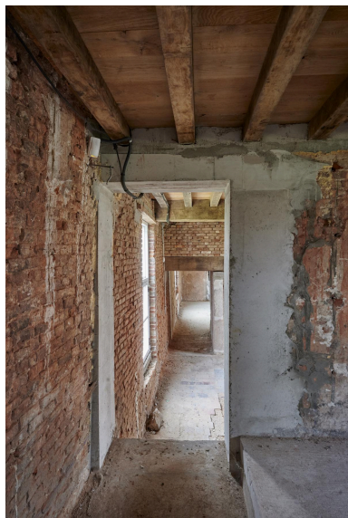
Rez-de-chaussée. Logis du XVIIe siècle. Vue en enfilade de l'espace de circulation depuis l'arrière-cuisine. Phot. Pierre Thibaut IVR32_20236200142NUCA
