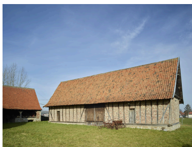
Grange nord. Vue prise depuis la cour intérieure. Phot. Pierre Thibaut IVR32_20236200123NUCA
