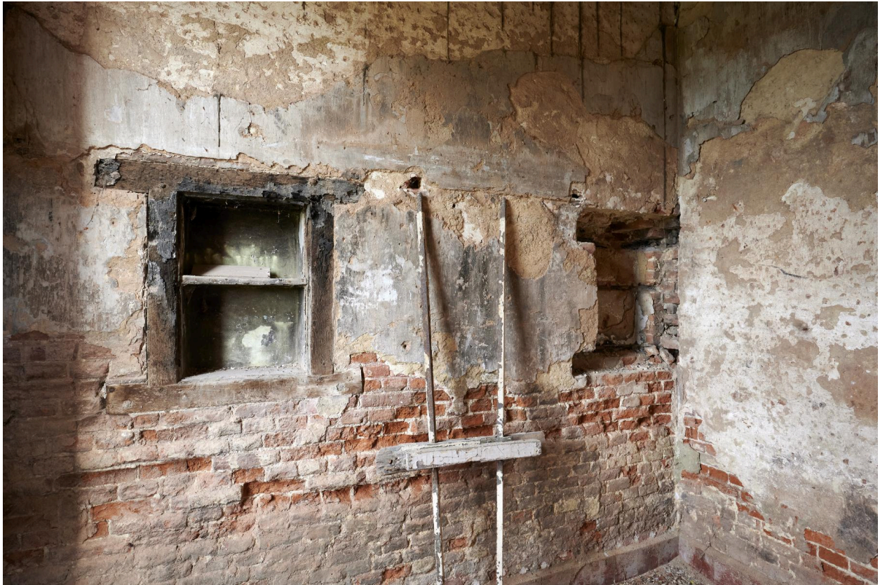
Rez-de-chaussée. Réduit du logis du XVIe siècle.
