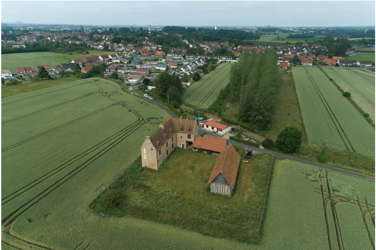
Vue aérienne depuis l'est.
