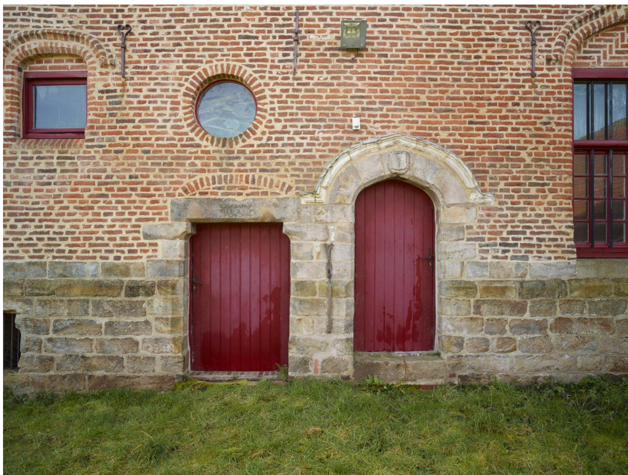
À droite, porte menant aux cuisines du logis du XVIIe siècle. À gauche, porte menant à la cave.
