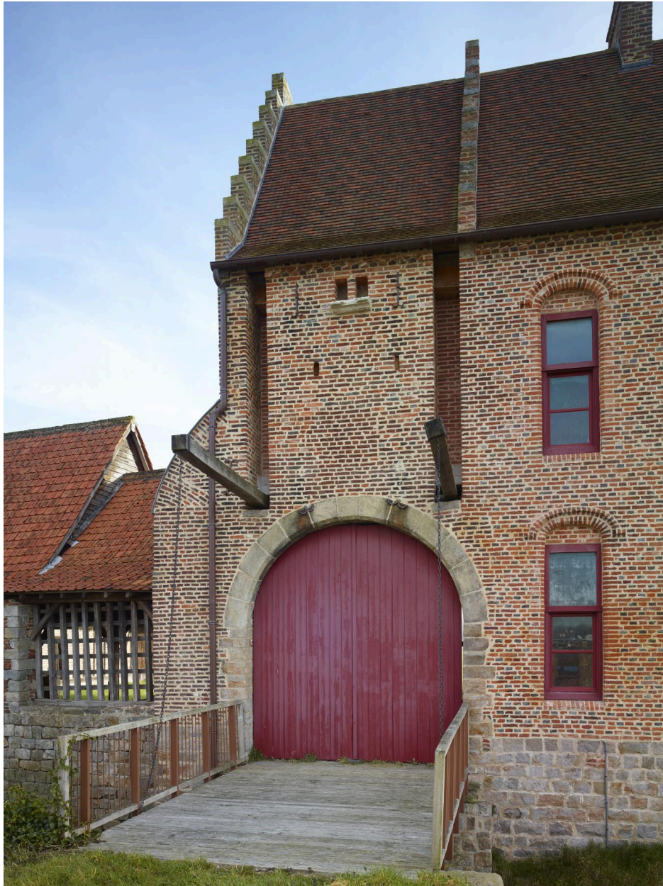
Tour-porche et porterie. Vue depuis la rue.
