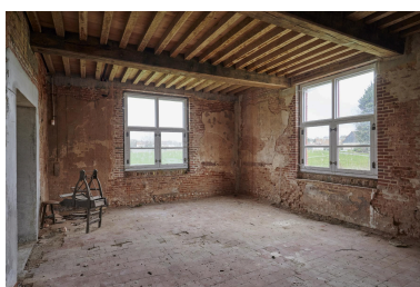
Rez-de-chaussée. Salle principale du logis du XVIe siècle. Phot. Pierre Thibaut IVR32_20236200129NUCA
