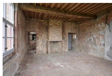
Rez-de-chaussée. Salle principale du logis du XVIe siècle. Vue vers le réduit, l'entrée principale et la cheminée. Phot. Pierre Thibaut IVR32_20236200152NUCA
