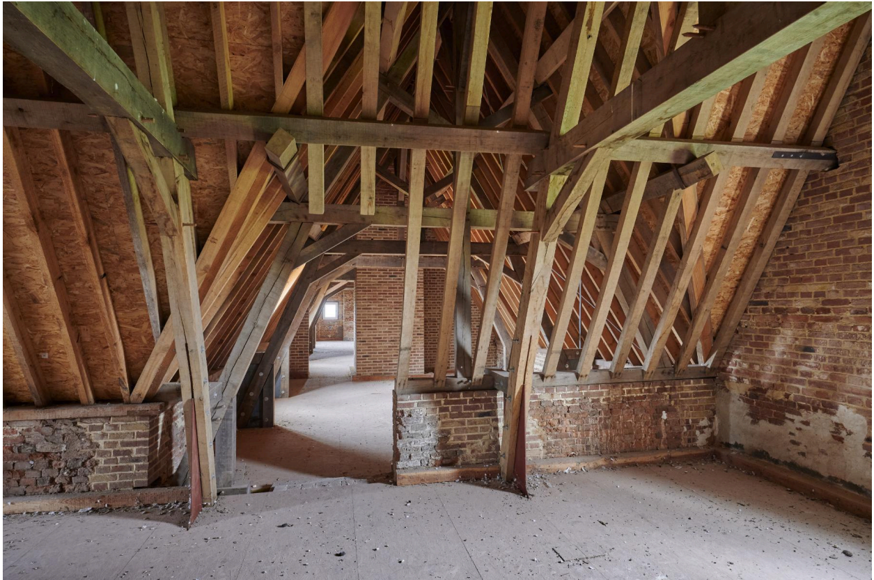
Combles. Logis du XVI e siècle. Vue vers les combles du logis du XVII e siècle.
