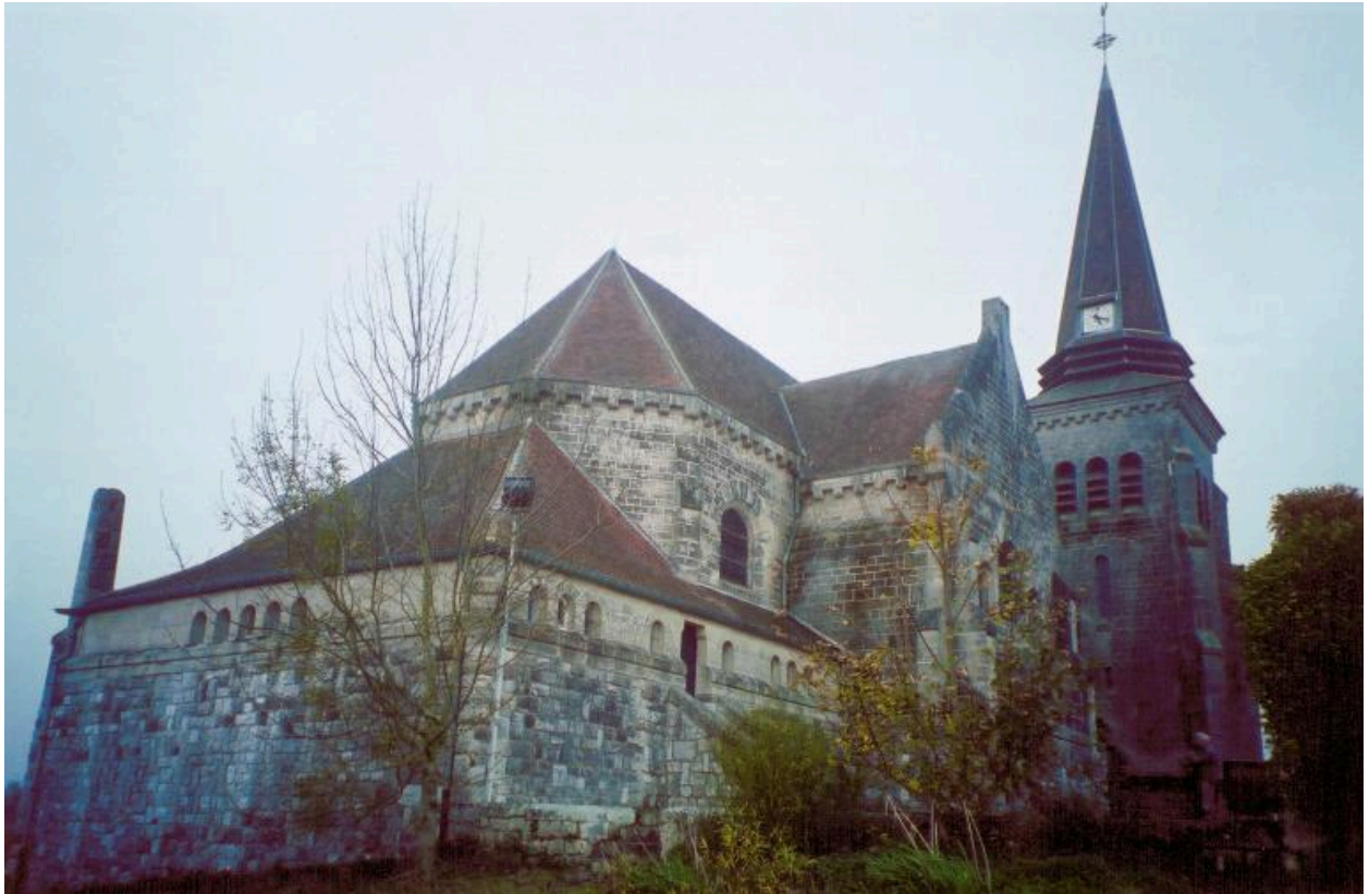
Façade postérieure sud.
