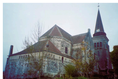
Façade postérieure sud. Phot. Gilles-Henri Bailly IVR22_20158005284NUCA
