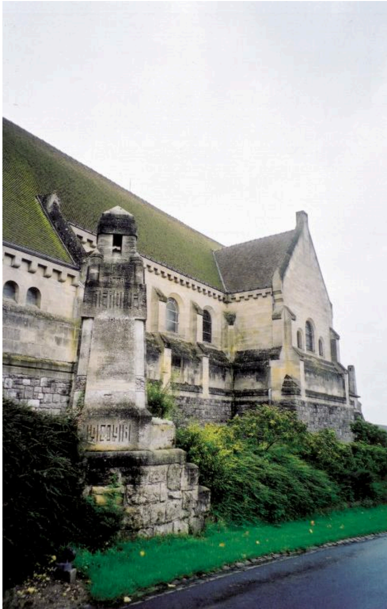
Façade latérale nord avec la lanterne des morts.
