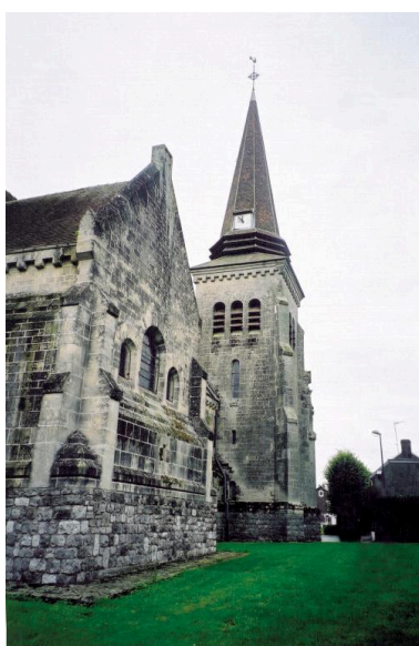
Façade latérale sud, avec le clocher. Phot. Gilles-Henri Bailly IVR22_20158005286NUCA
