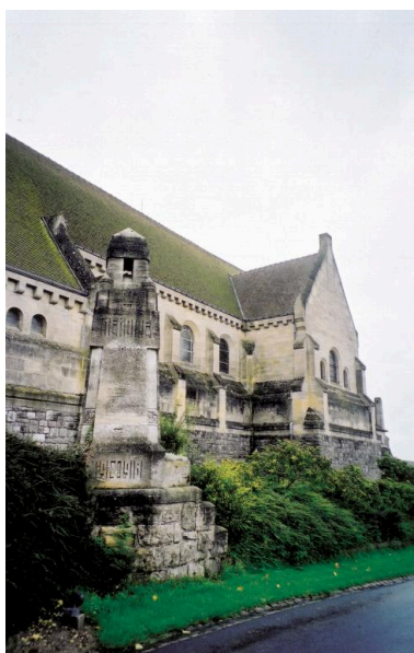
Façade latérale nord avec la lanterne des morts. Phot. Gilles-Henri Bailly IVR22_20158005283NUCA
