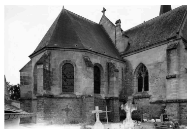
Choeur et bras nord du transept. Phot. Jean-Michel Perrin IVR22_19846001062X
