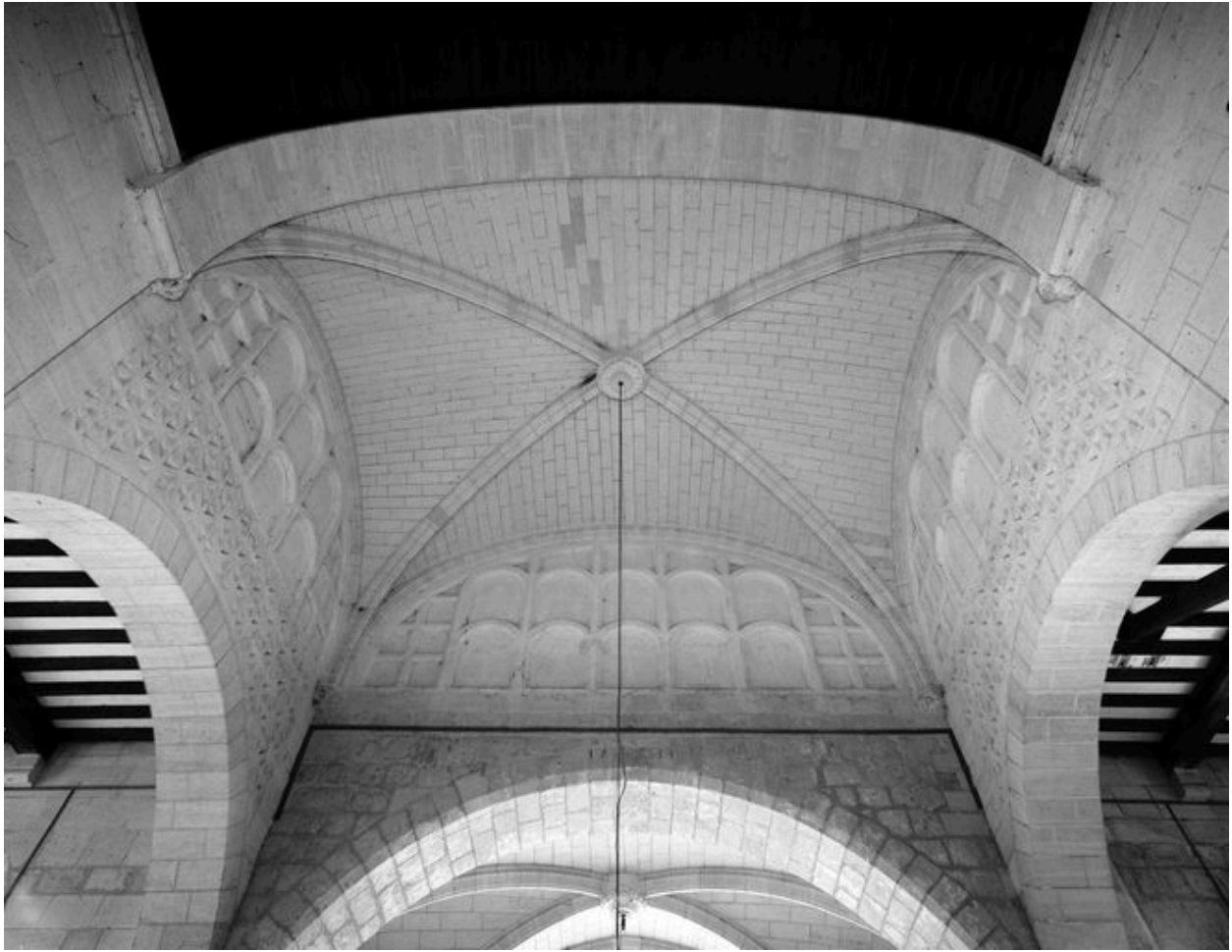
Voûte de la croisée du transept.
