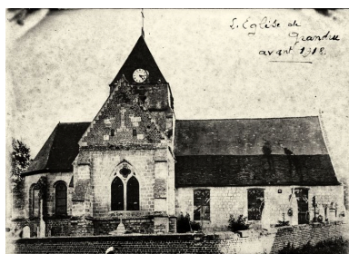
Elévation nord. Etat avant 1914 (AP). Phot. Jean-Michel Périn IVR22_19846001096XB
