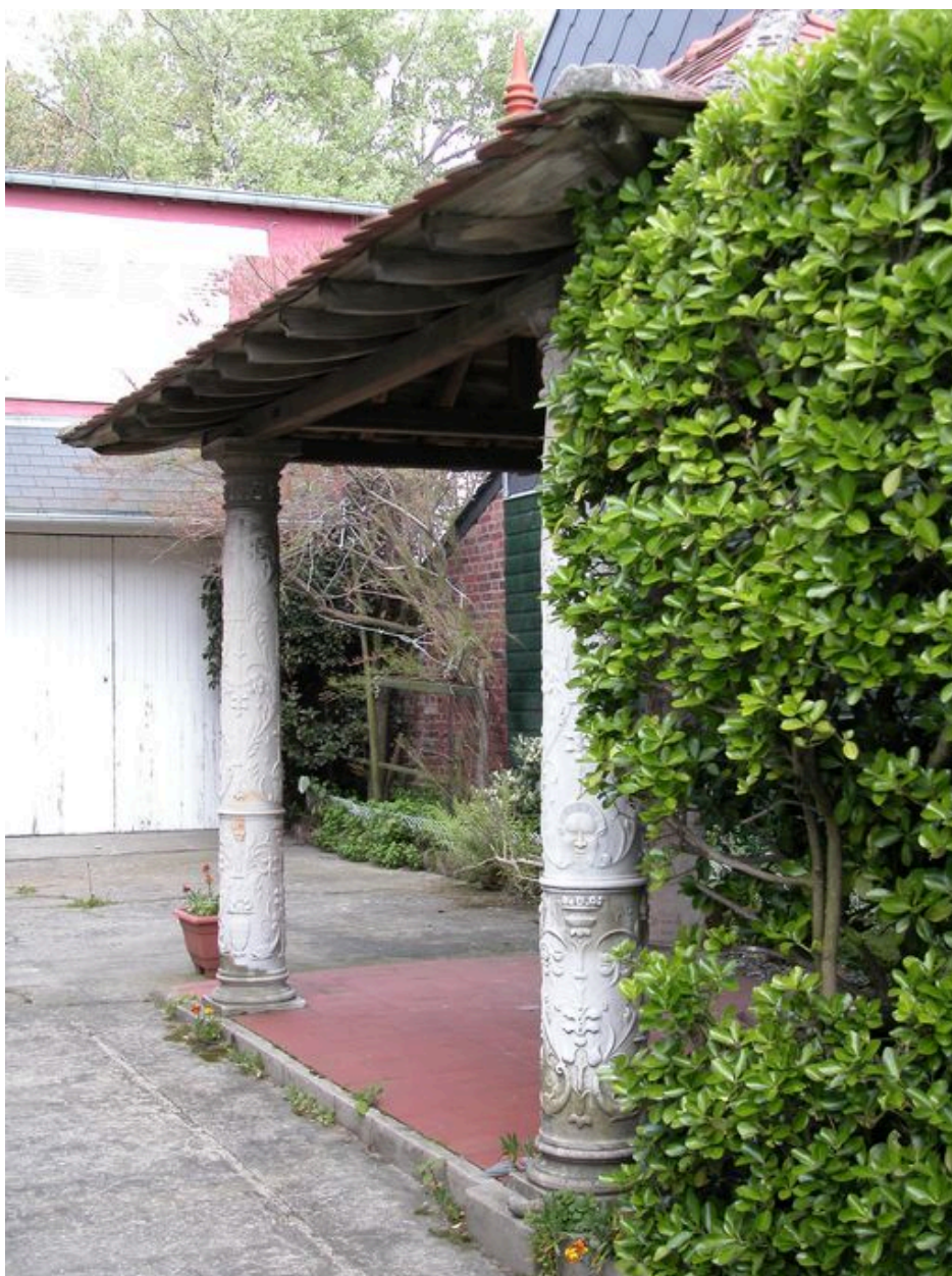
Détail de la fabrique de jardin.
