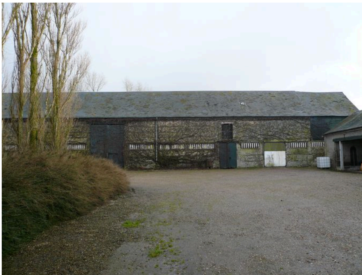
Vue de la grange au sud.
