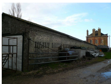
Vue postérieure de ces étables. Phot. Inès Guérin IVR22_20078005589NUCA
