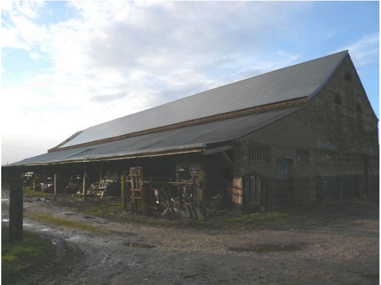
Vue postérieure de cette grange.
