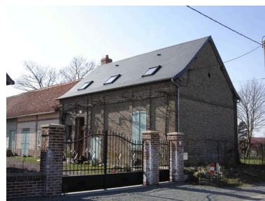
Vue détaillée du logis. Phot. Inès Guérin IVR22_20058005299NUCA
