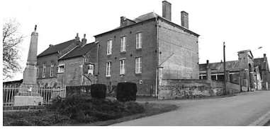
Elévation postérieure de la mairie et de la salle de classe. Phot. Xavier-Philippe Guiochon IVR22_19980200832Z
