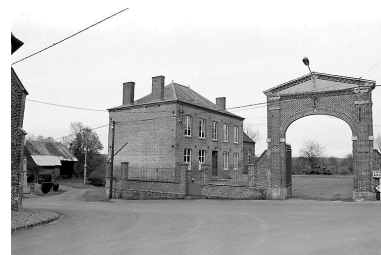
Mairie vue depuis l'ouest et portail d'entrée. Phot. Xavier-Philippe Guiochon IVR22_19980200833Z
