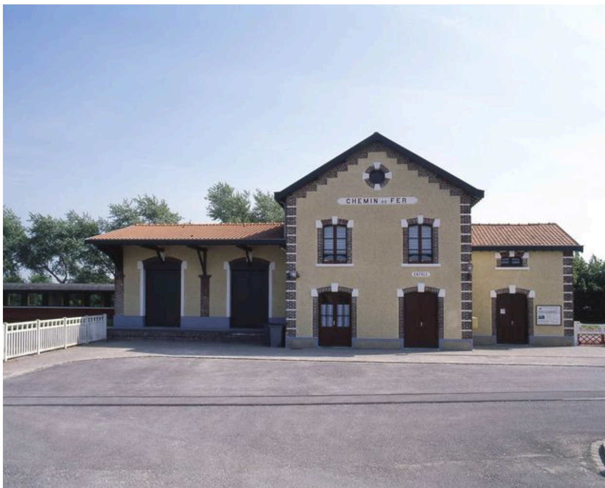
La gare du Crotoy, vue d'ensemble.
