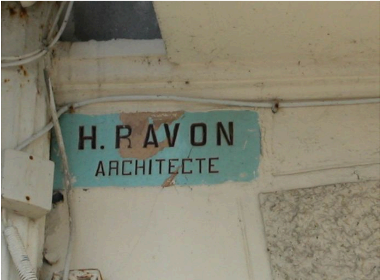
Détail du carreau de céramique portant signature de l'architecte H. Ravon.
