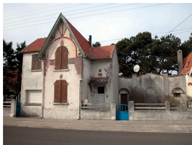
Vue d'ensemble, avec le mur aveugle du garage à droite.
