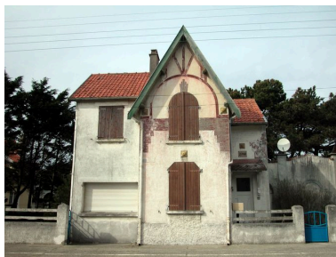
Élévation antérieure. Phot. Elisabeth Justome IVR22_20058002776NUCA
