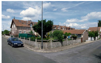
Vue générale de l'une des barres de logements. Phot. Thierry Lefébure IVR22_20106000420NUCA
