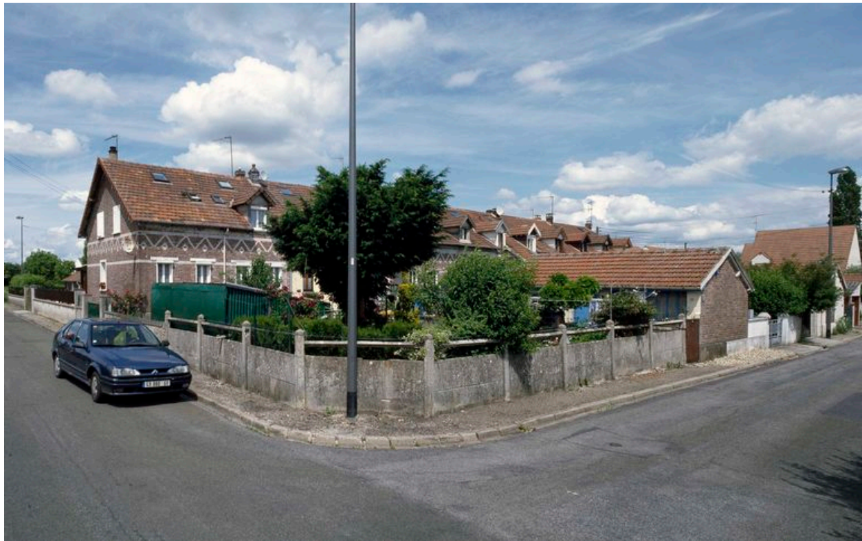
Vue générale de l'une des barres de logements.
