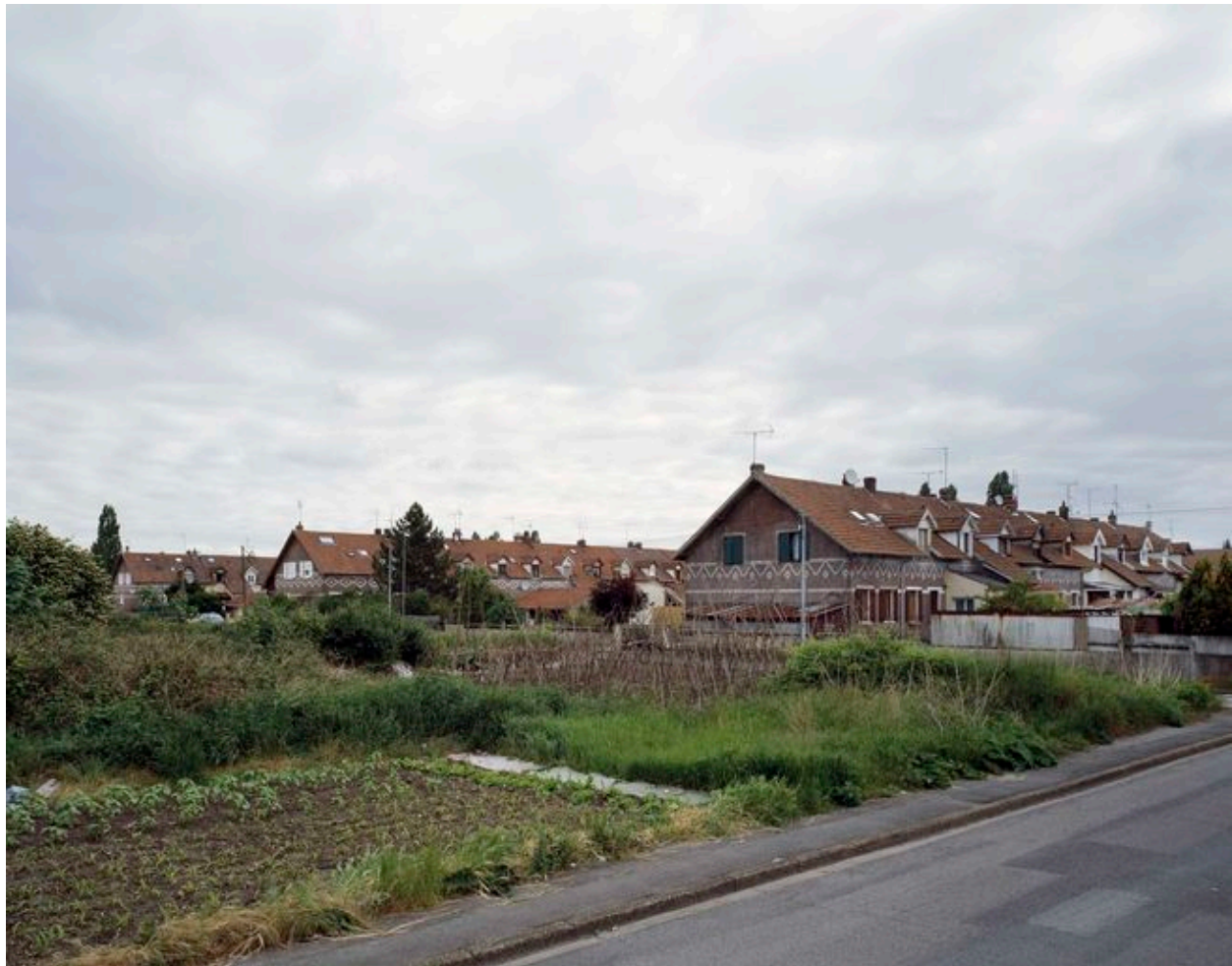
Immeubles à logements ouvriers d'une cité de la Cerabati.
