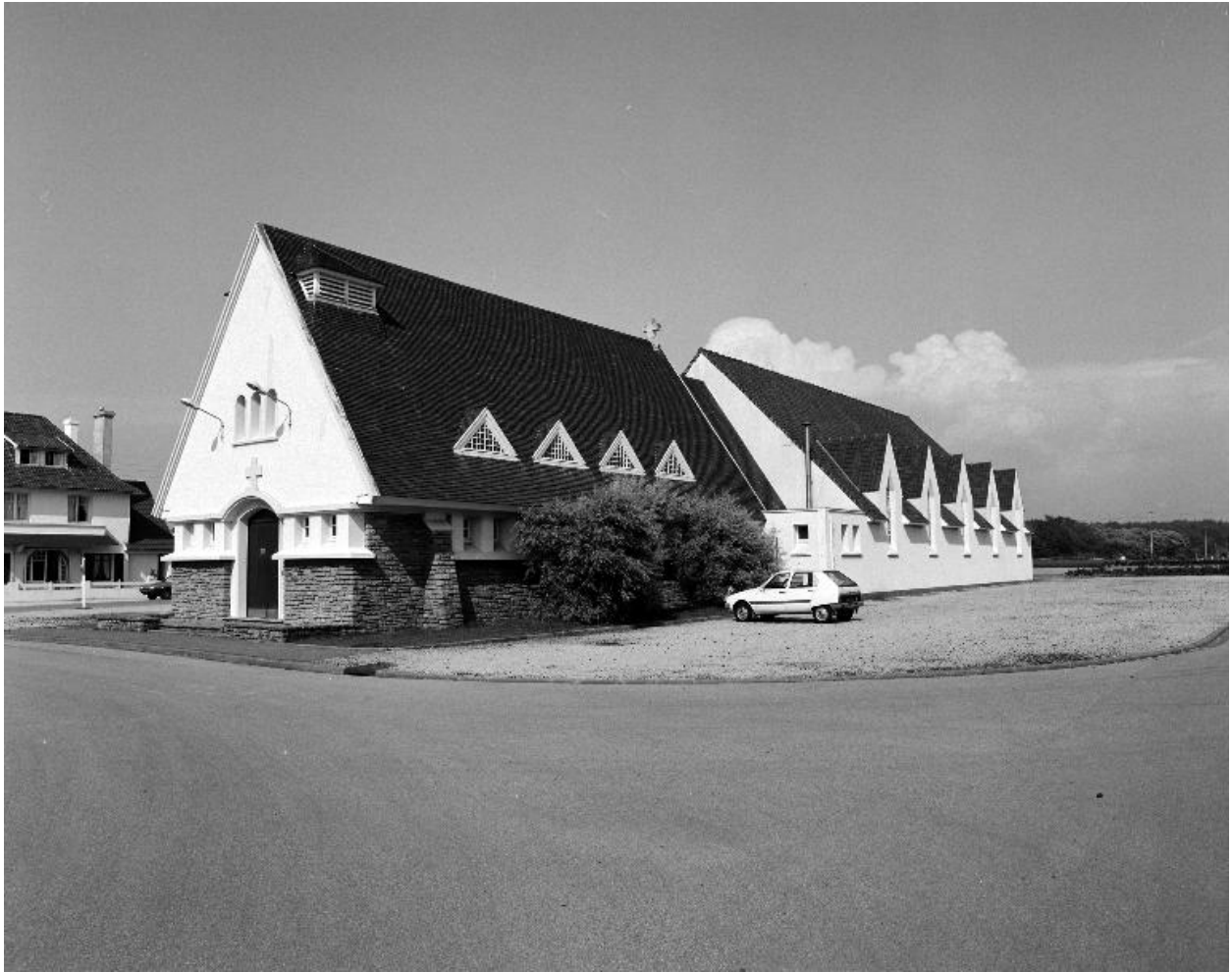
Vue d'angle sud-ouest.
