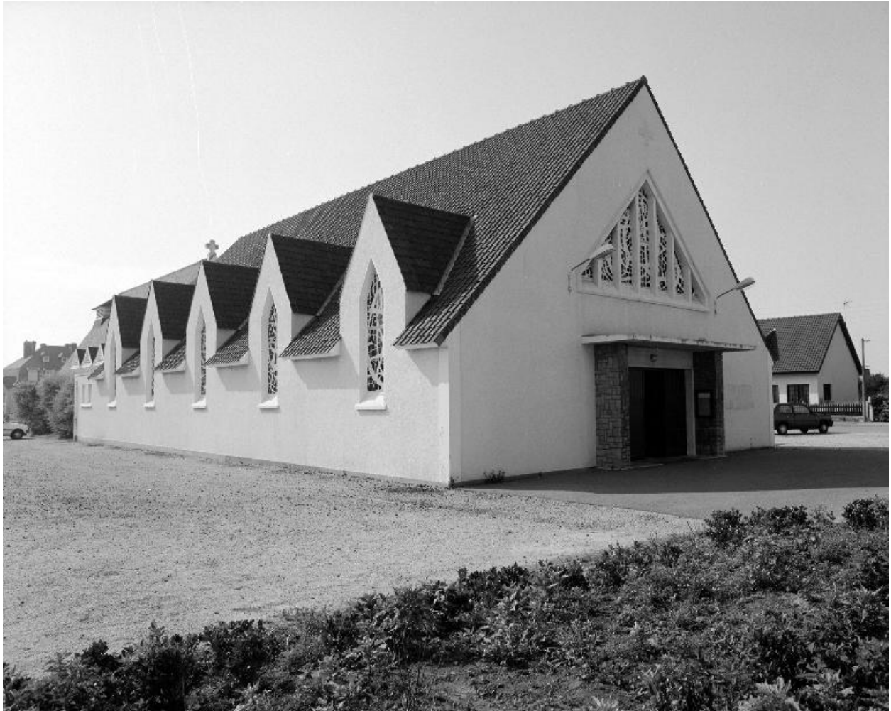
Vue d'angle sud-est.
