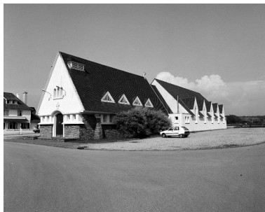
Vue d'angle sud-ouest. Phot. Philippe Dapvril IVR31_19916200391X
