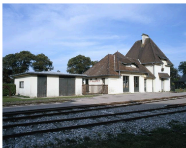
Élévation postérieure, côté rails. Phot. Marie-Laure Monnehay-Vulliet IVR22_20048000133XA
