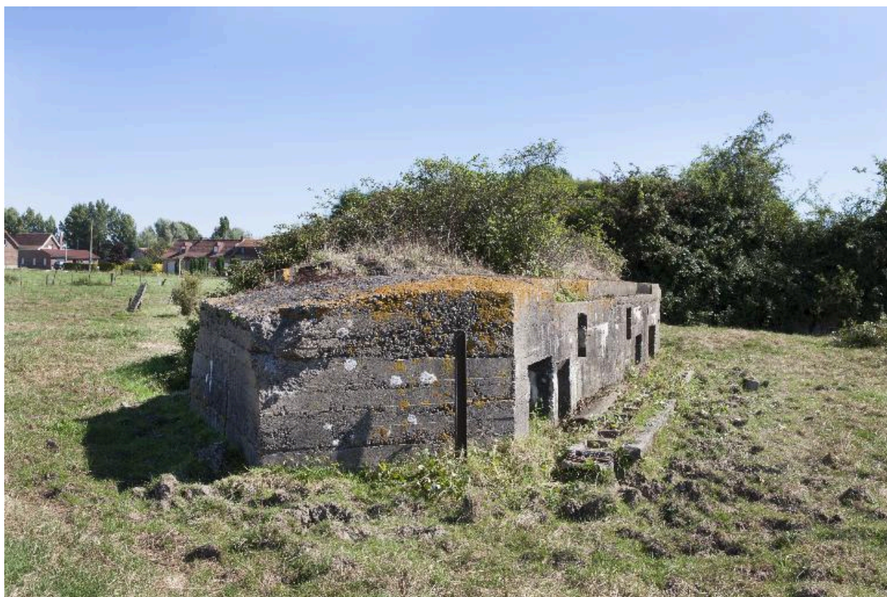
Vue générale vers le nord-est
