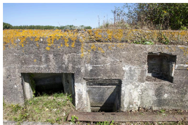
Entrée ouest Phot. Pierre Thibaut IVR32_20165901336NUCA
