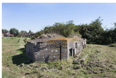
Vue générale vers le nord-est Phot. Pierre Thibaut IVR32_20165901338NUCA
