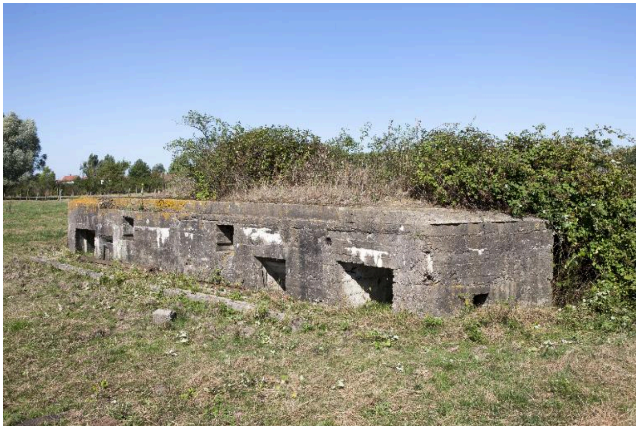
Vue générale vers le nord-ouest
