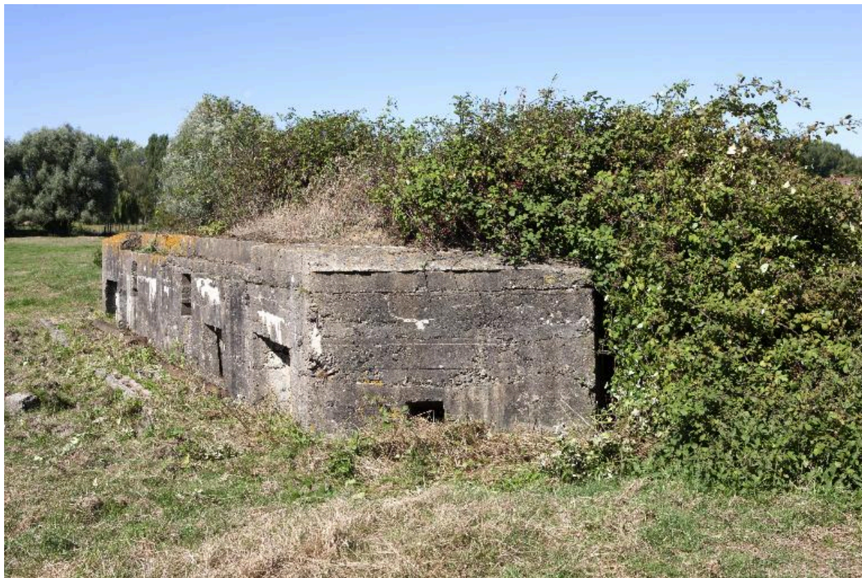
Vue générale vers le nord-ouest
