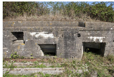
Entrée est Phot. Pierre Thibaut IVR32_20165901337NUCA
