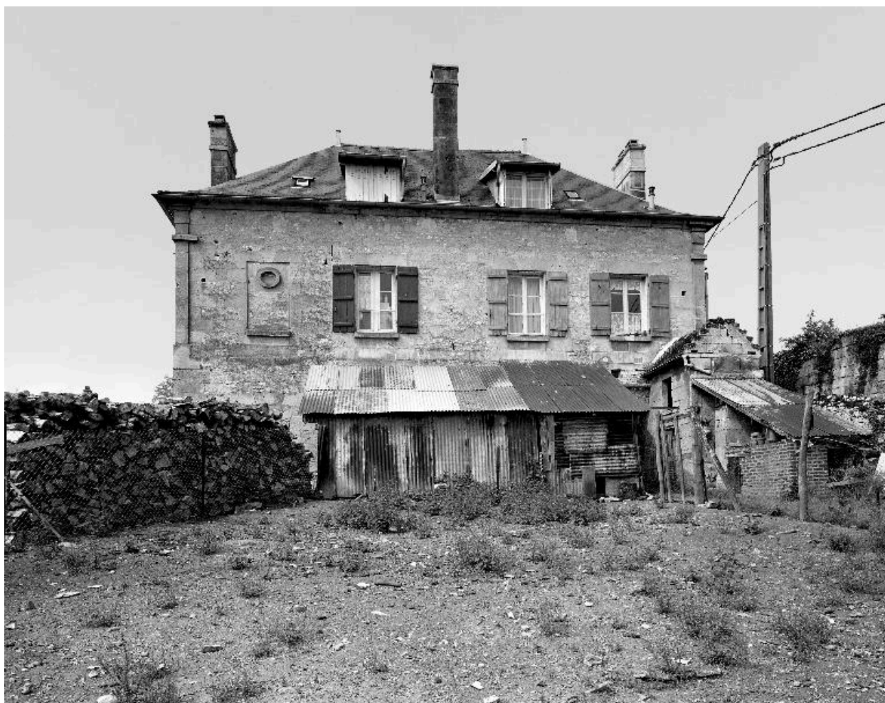
Vue générale de l'élévation arrière (nord-est).
