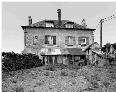
Vue générale de l'élévation arrière (nord-est). Phot. Thierry Lefébure IVR22_19900200874V
