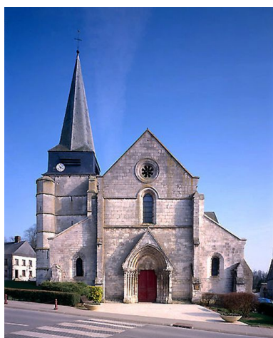
Façade occidentale. Phot. Franck Bürjes IVR22_19990200903VA
