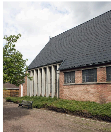
Élévation extérieure côté gauche. Phot. Pierre Thibaut IVR31_20155900244NUCA
