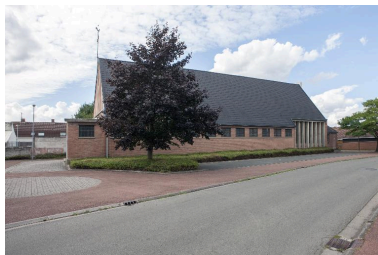
Élévation extérieur côté droit. Phot. Pierre Thibaut IVR31_20155900245NUCA
