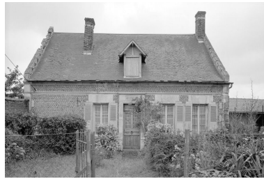
Logis. Elévation antérieure. Phot. Jean-Michel Perrin IVR22_19846000959X
